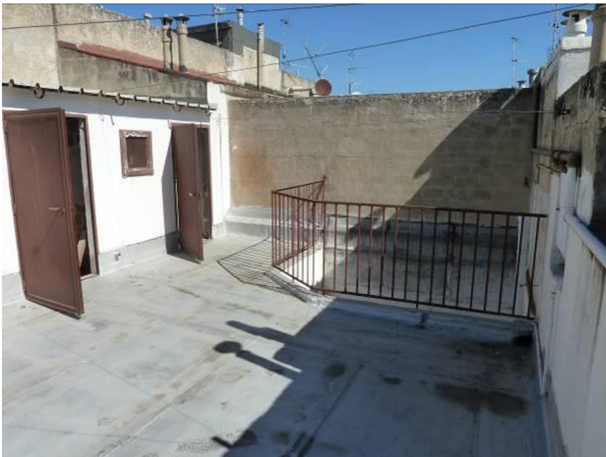
11) Dettaglio del passaggio dal vano lavatoio comune e il terrazzo della copertura
