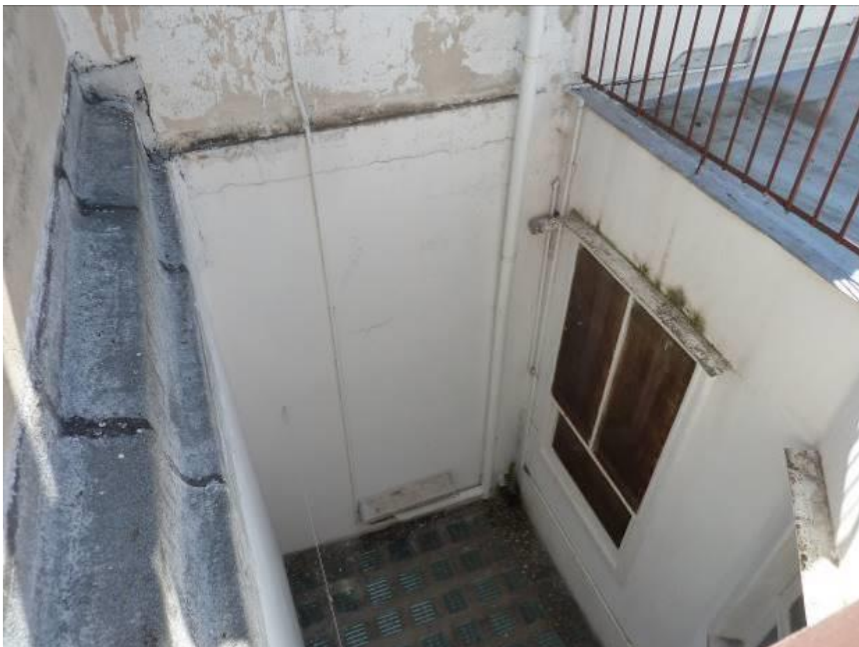
12) Dettaglio del cavedio posto a piano con U.I. censita al Fg.159 mappale 3630/5
