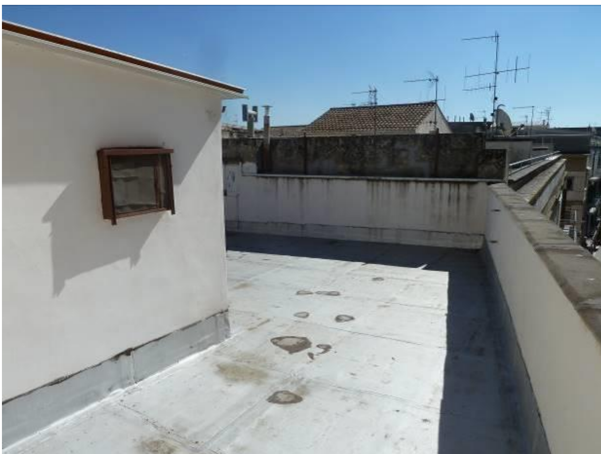
16) Dettaglio di corpo ripostigli e terrazzo di copertura al P.3° dello stabile de quo
