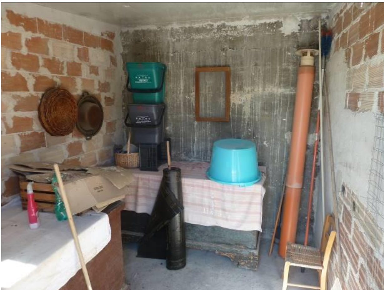
14) Dettaglio all'interno del vano ripostiglio 1 posto a Piano 3° dell'edificio de quo
