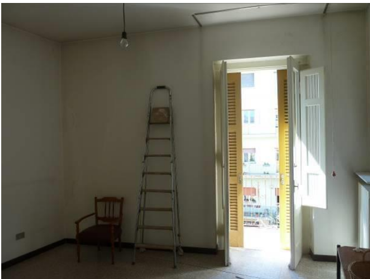
08) Dettaglio della camera dell'U.I. in questione, che affaccia su Via Annunziatella
