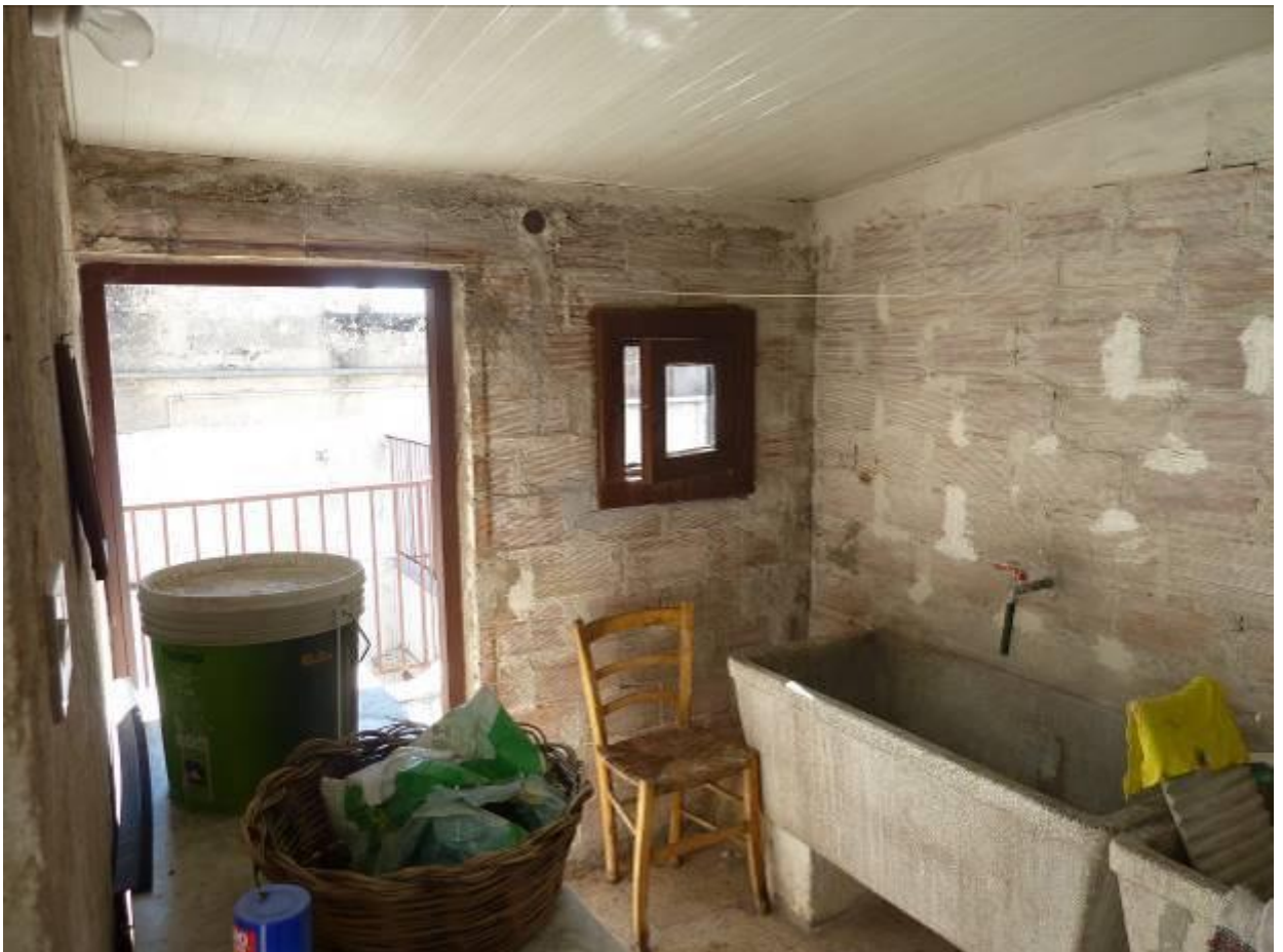
10) Dettaglio del vano lavatoio comune, e di passaggio per il terrazzo di copertura
