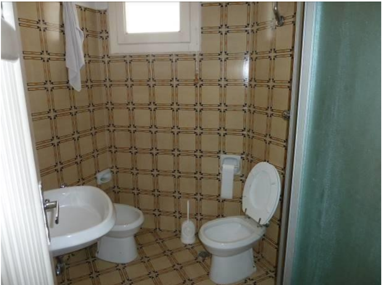
06) Particolare vano WC interno all'U.I. considerata (Fg.159 mappale 3630 sub.5)
