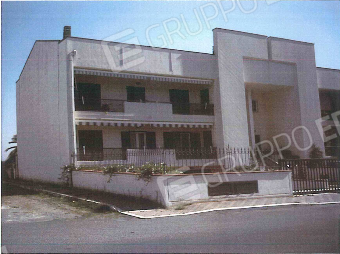
FOTO N.1 ESTERNO INGRESSO VIA ANZIO - RIPRESA DA NORD A SUD
