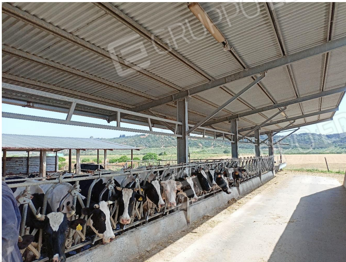
Tettoia p.lla 130 sub 4 CORPO 8
