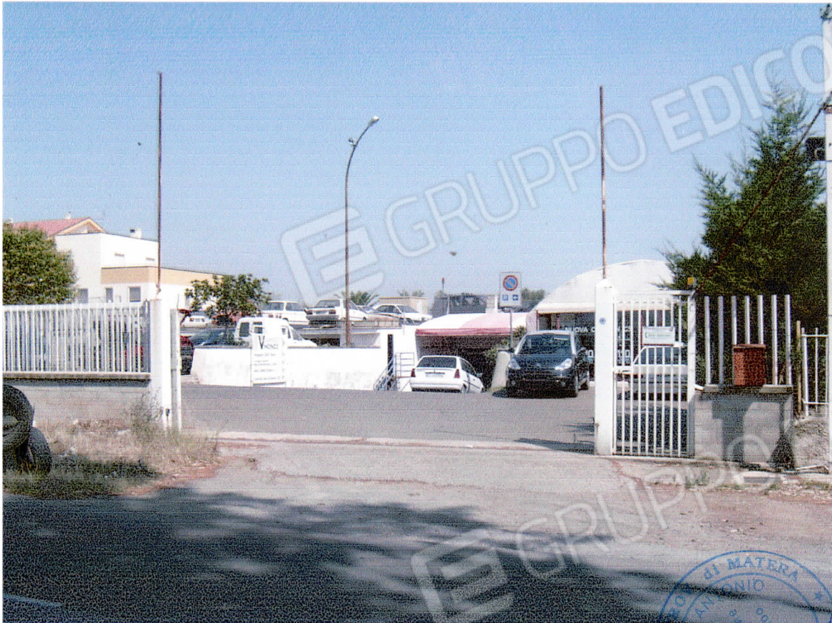
Foto n. 4 - Ingresso da Viale Salerno - Autofficina - Immobile B e C
