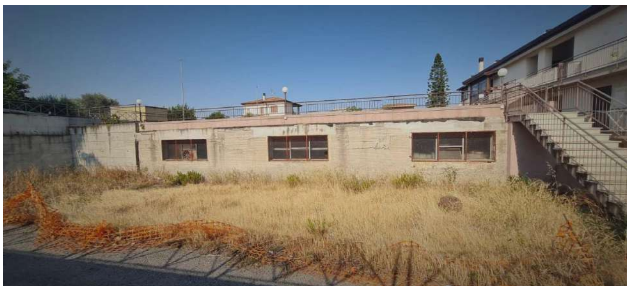
Figura 9 - Prospetto laterale sinistro
