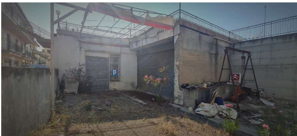
Figura 7 - Vista esterna dal piazzale antistante
