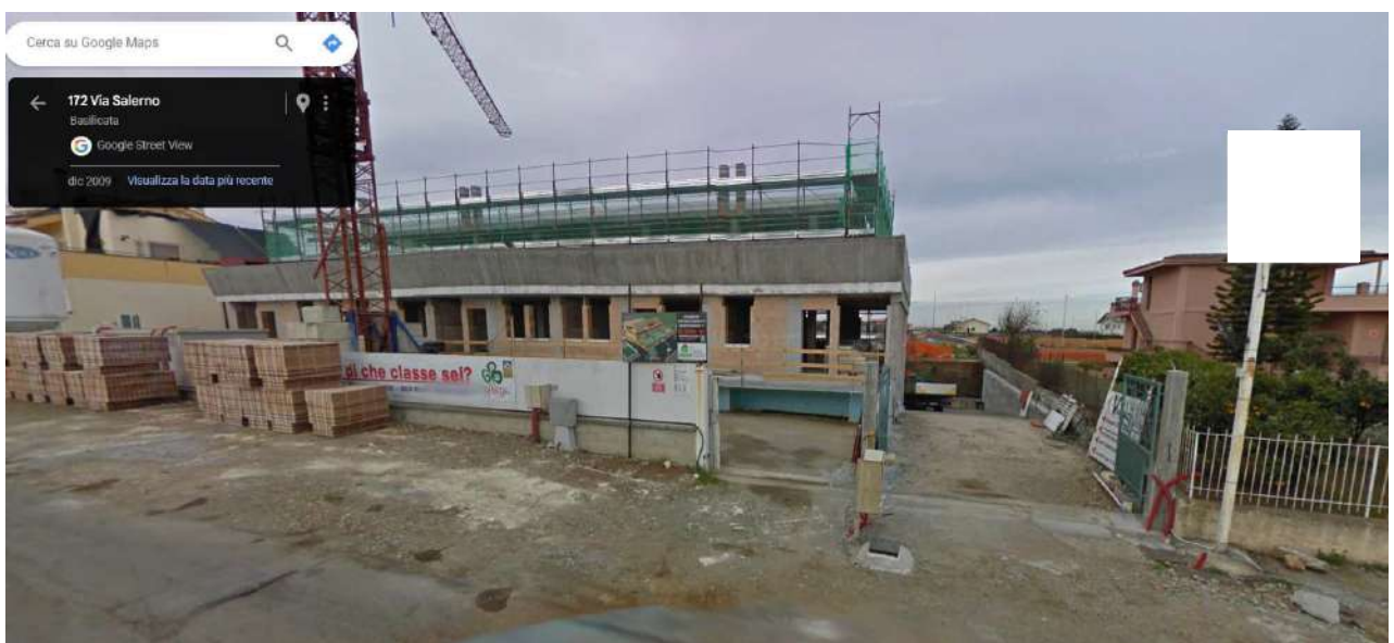
Figura 20 e 21 - Stato dell'area a fine 2009 (cantiere in avanzato stato di completamento)
