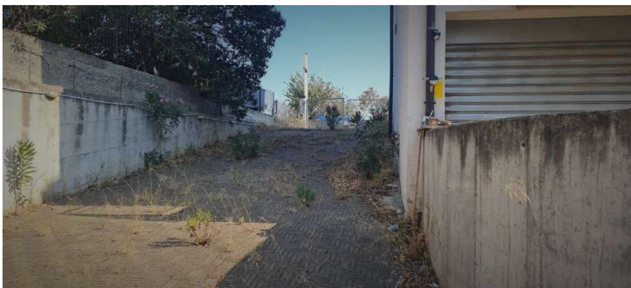
Figura 6 - Rampa carrabile di accesso dal Viale Salerno
