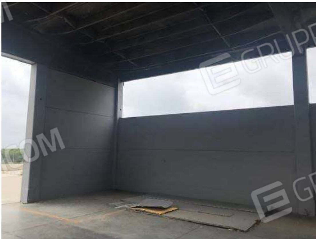
Foto 20 – Interni del capannone – Zona prossima all’ingresso principale anteriore. Si evince la totale assenza degli impianti e delle finestre “a nastro” preesistenti.
