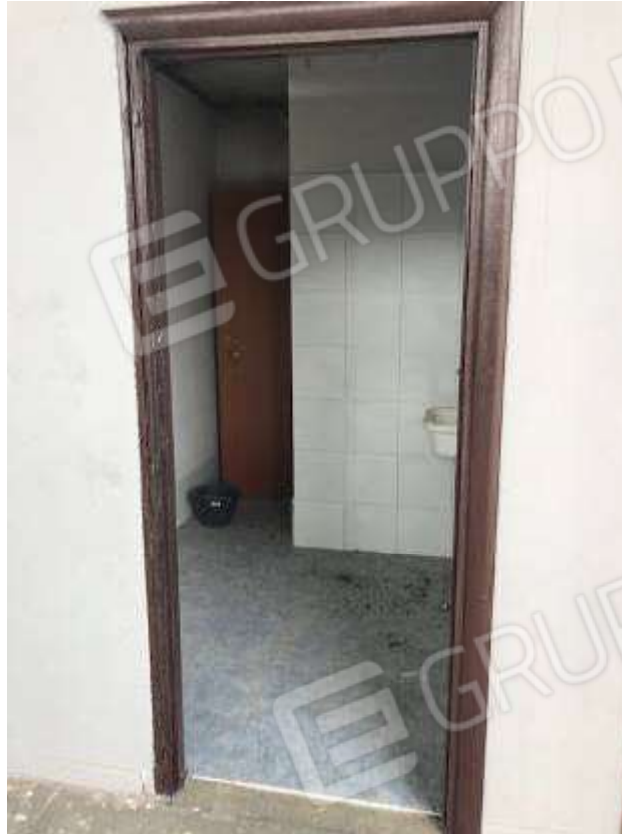
Foto 15 – Interni del capannone – Bagno centrale. Le mostre ed il telaio fisso risultano parzialmente danneggiati dal fuoco.
