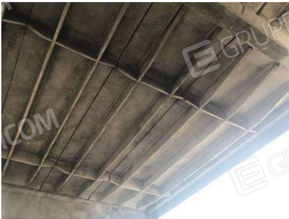
Foto 10 – Interni del capannone – Intradosso della copertura (ultima campata, entrando dall'ingresso principale - zona di destra) La soletta e le nervature degli elementi prefabbricati non sono state danneggiate dall'incendio
