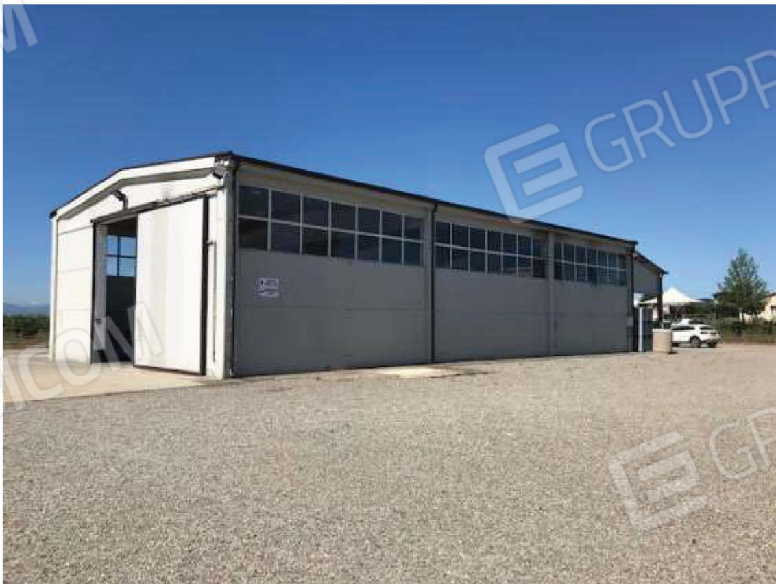
Foto 04 – Vista anteriore del capannone e dell'ingresso posteriore
