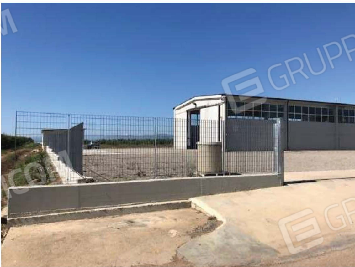
Foto 02 – Vista del capannone dall'ingresso di sinistra
