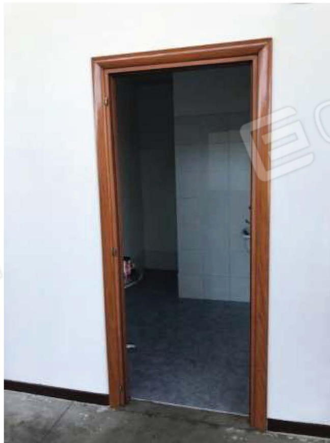
Foto 06 – Dettaglio dell'ingresso nel WC1
