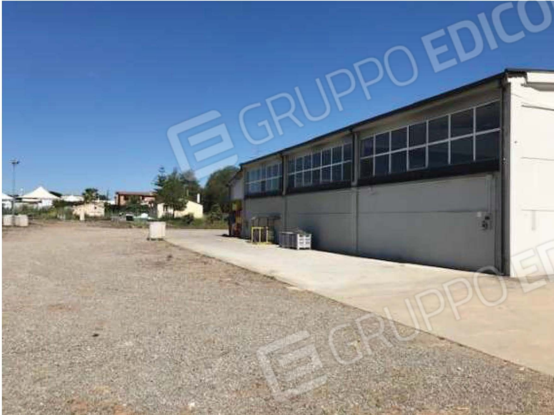
Foto 07 – Vista posteriore del capannone
