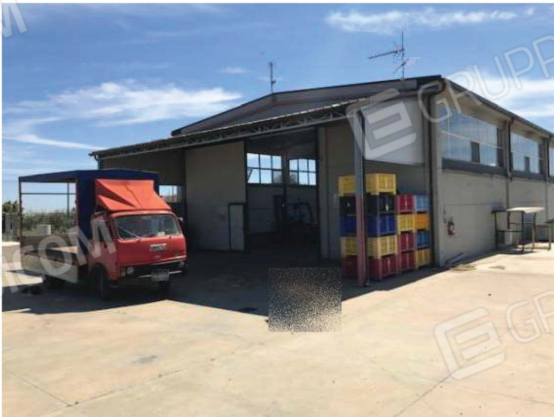
Foto 08 – Vista della tettoia realizzata anteriormente al capannone
