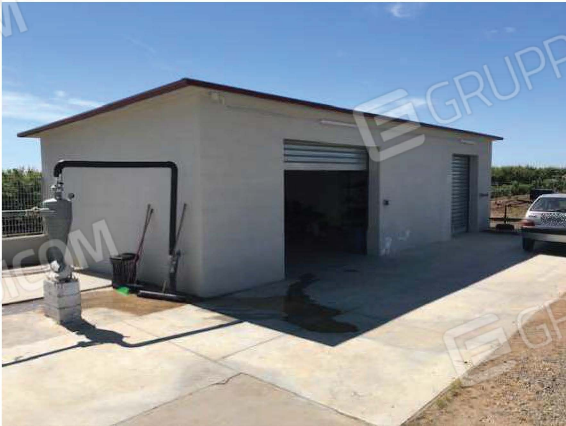
Foto 06 – Vista del deposito posteriore
