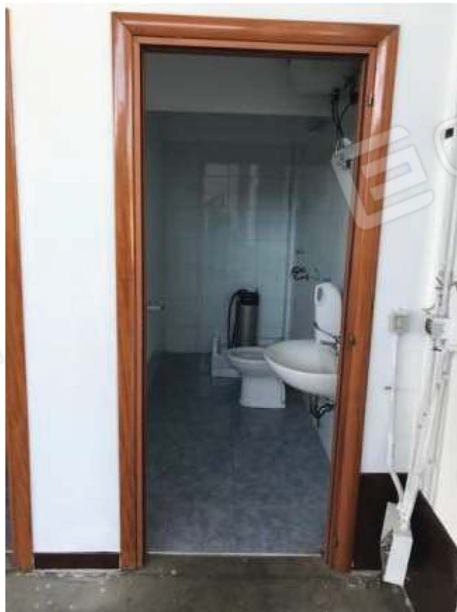
Foto 08 – Dettaglio dell'ingresso nel WC2
