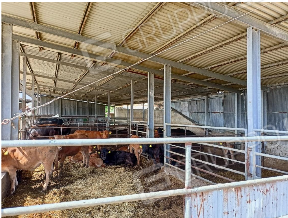
Tettoia stalla p.lla 130 sub 4 CORPO 7
