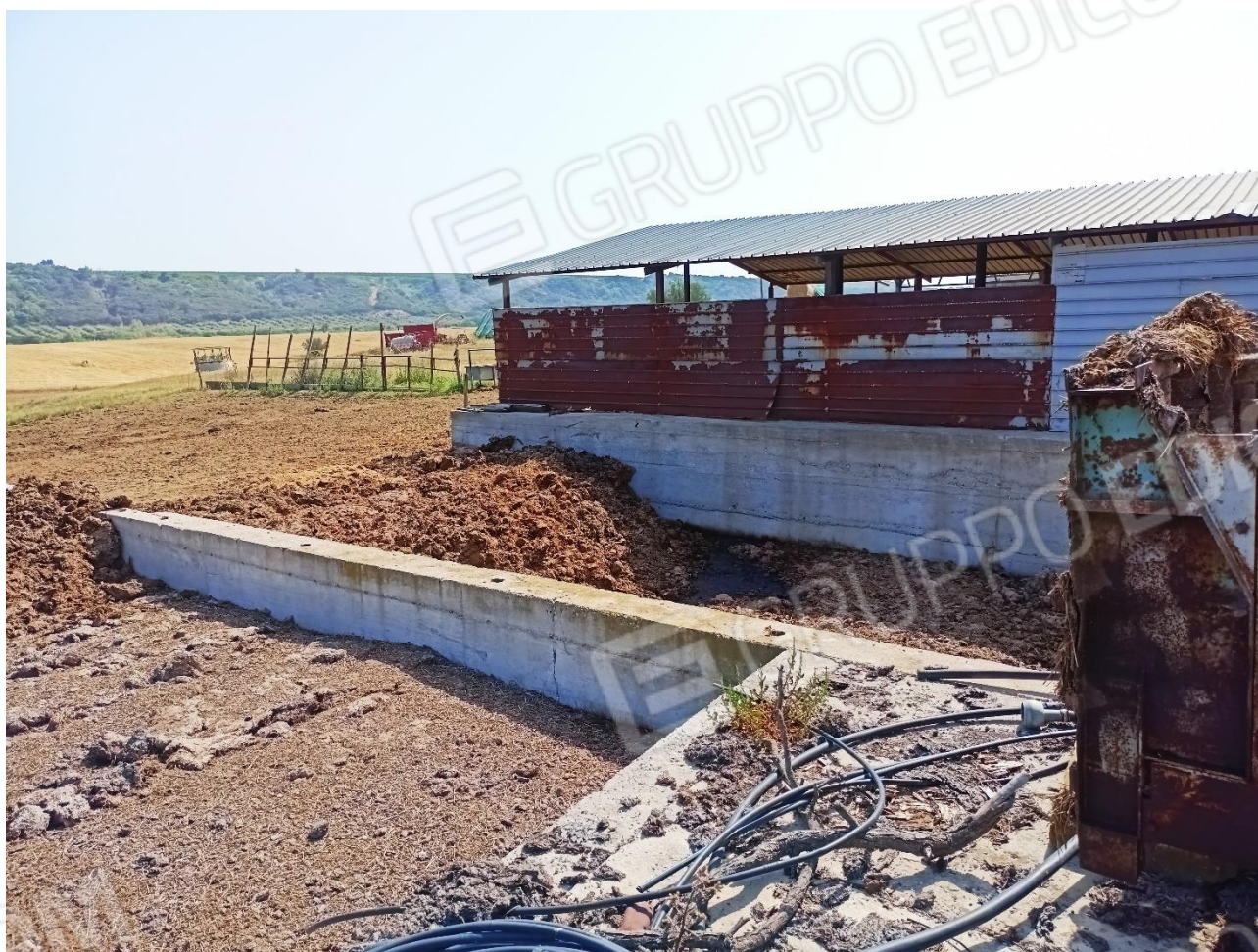
Tettoia stalla p.lla 130 sub 4 CORPO 5
