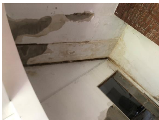
INTERNO LOCALI EX DEPOSITO INFILTRATI E DEVASTATI
