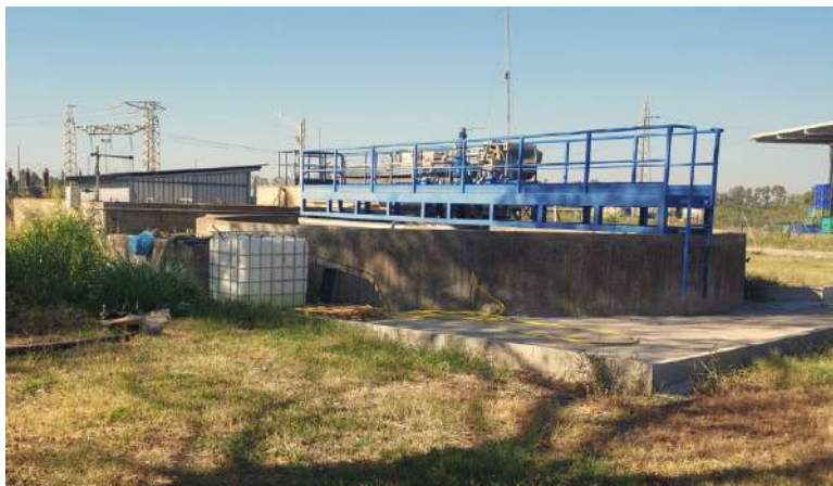
g) Vasca di raccolta acque per la lavorazione del prodotto
