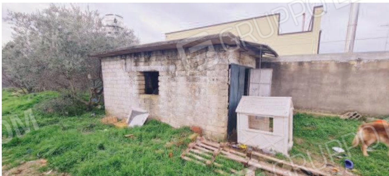
Figura 17 - deposito su area esterna
