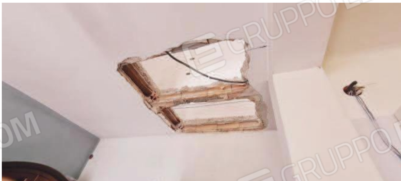
Figura 14 - piano terra (apertura nel solaio)
