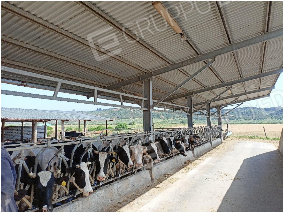
Tettoia p.lla 130 sub 4 CORPO 8
