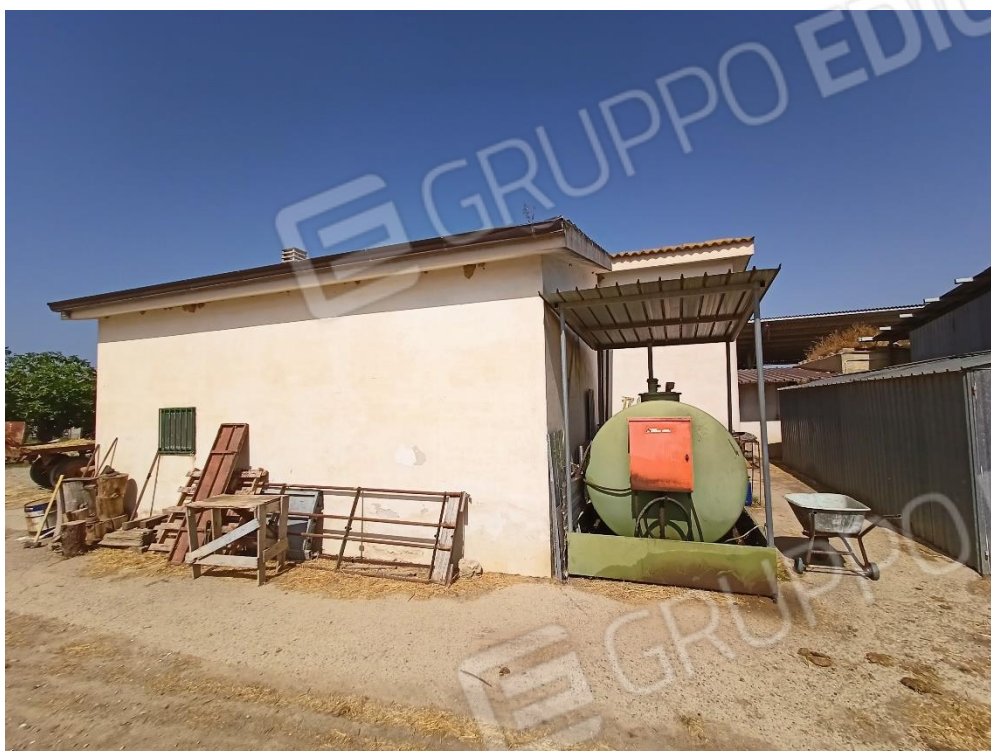
Deposito p.lla 130 sub 4 CORPO 9
