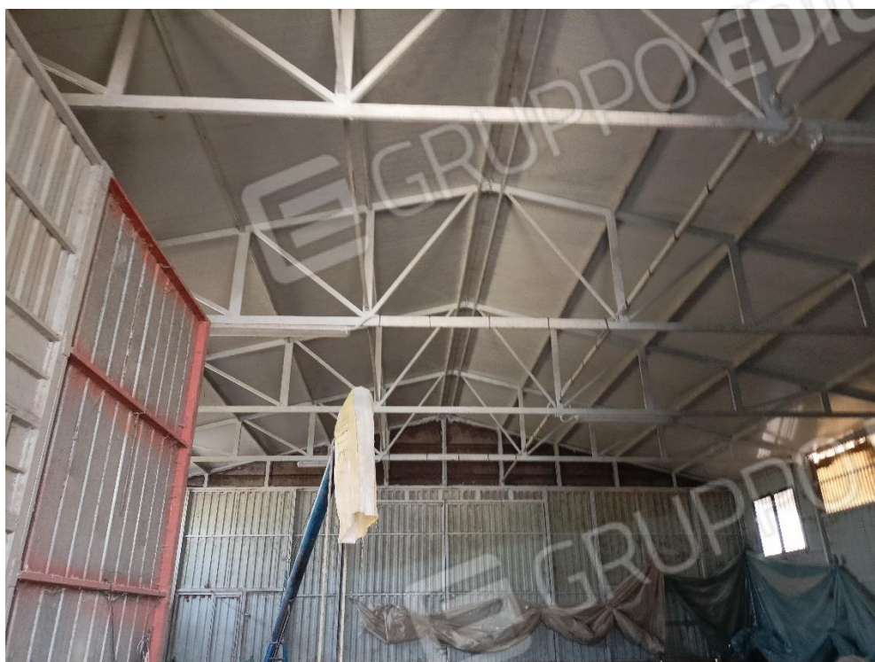
Deposito p.lla 130 sub 4 CORPO 3
