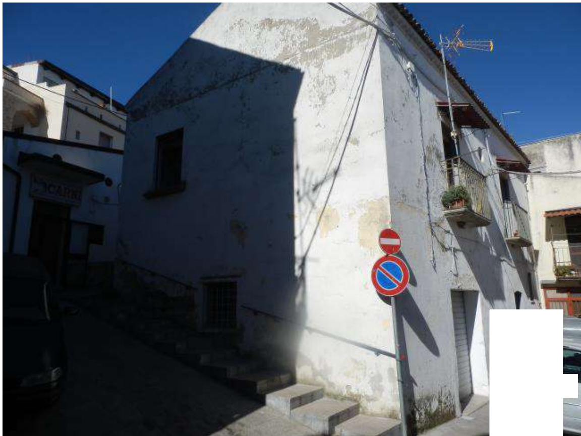
edificio in via Cirillo angolo via dei Caduti
