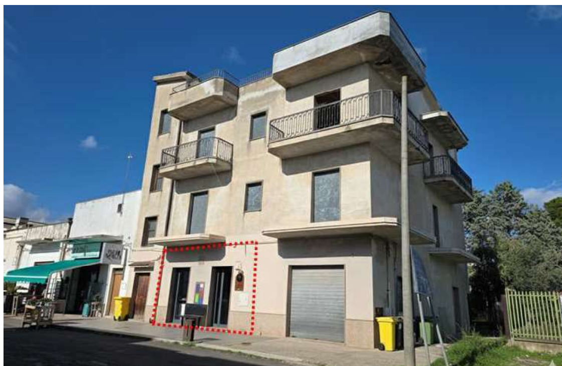
Figura 60 - Vista esterna con individuazione del bene nel fabbricato
