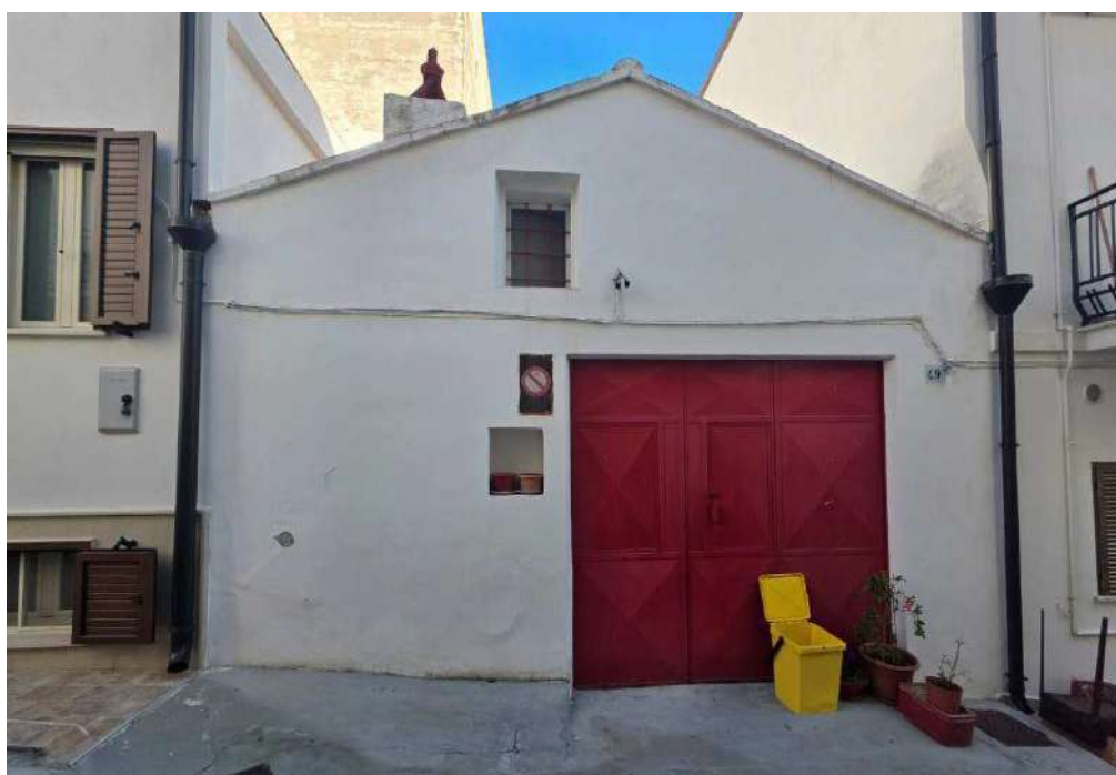
Figura 82 - Prospetto principale su via C. Colombo
