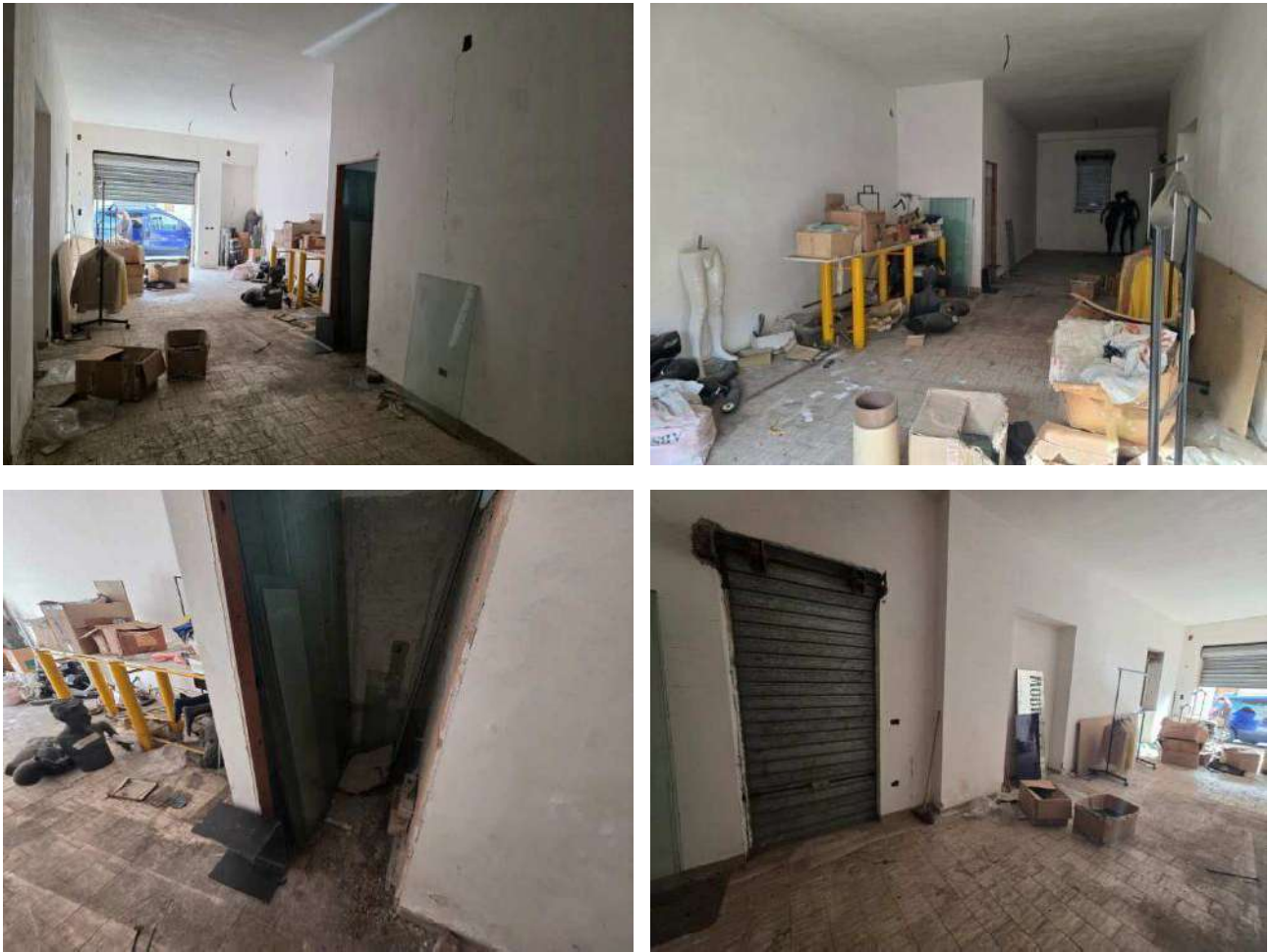
Figura da 17 a 21 - Vista esterna e viste interne dell'unità immobiliare
