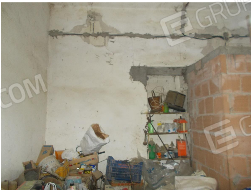
Foto n. 10 – Muratura perimetrale bagno
