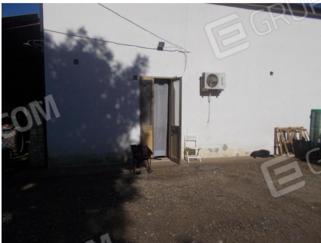
Foto n. 2 – Porta esterna di entrata locale deposito
