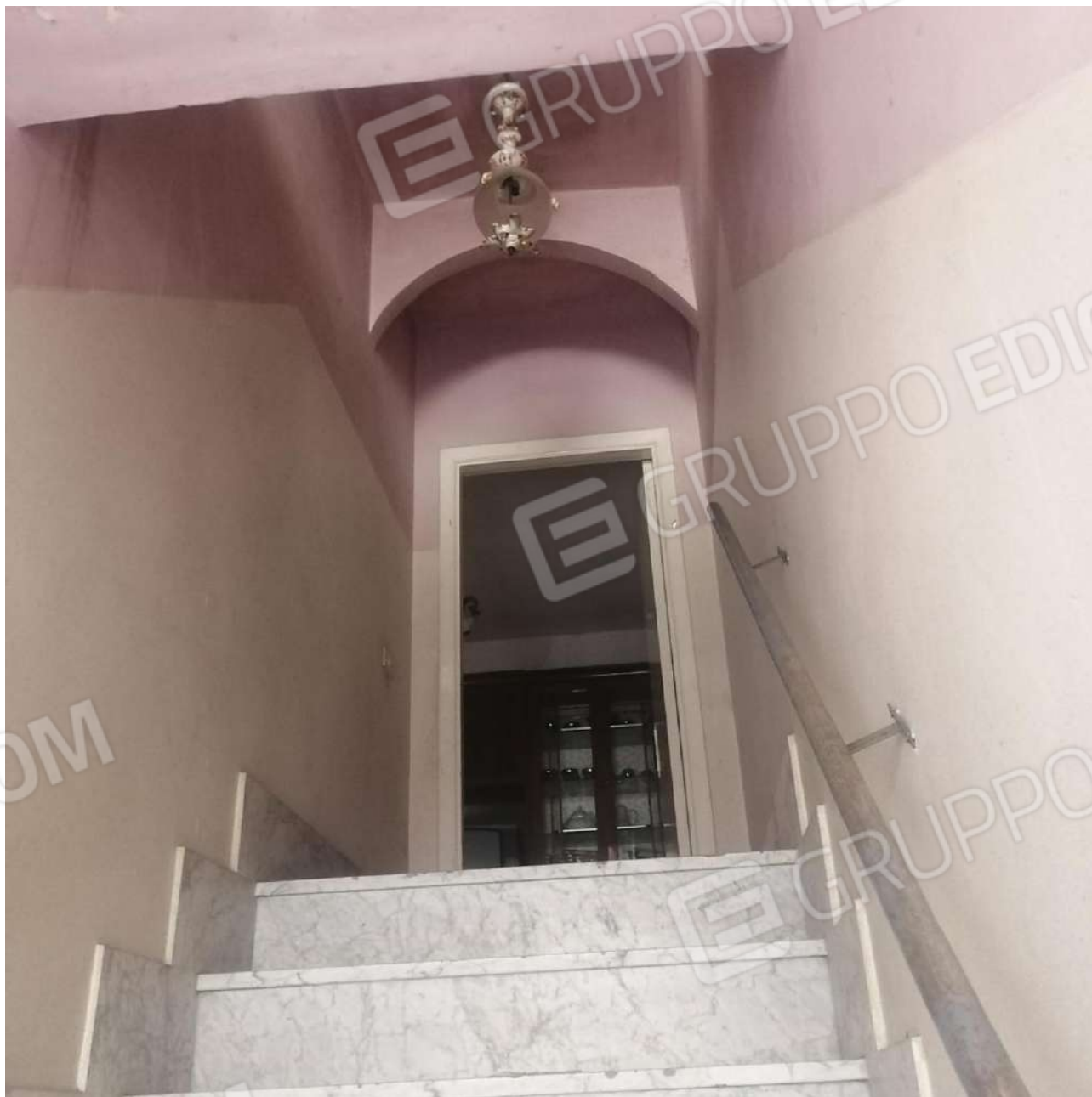
RAMPA DI ACCESSO AL PIANO PRIMO
