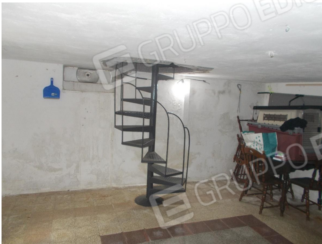
Foto n. 15 – Interno Deposito Comunicante Fabbricato
