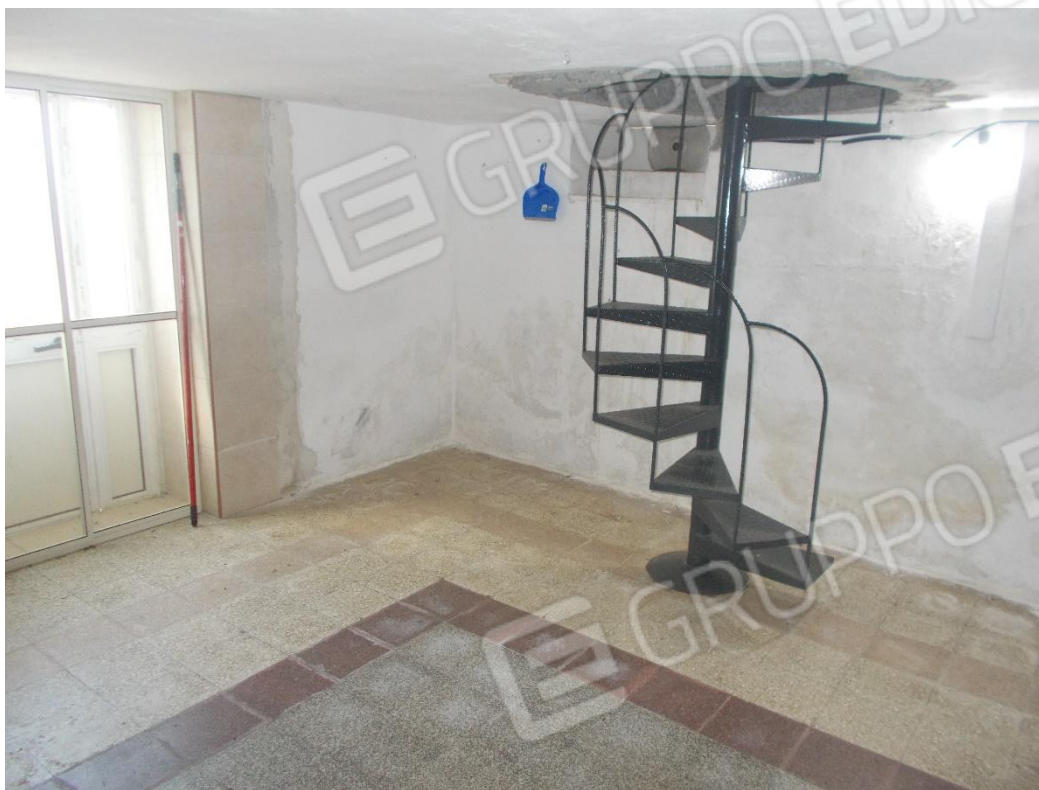
Foto n. 13 – Interno Deposito Comunicante Fabbricato
