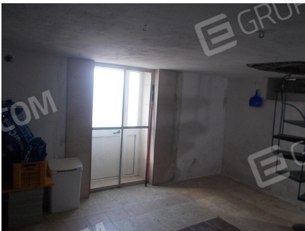
Foto n. 16 – Interno Deposito Comunicante Fabbricato
