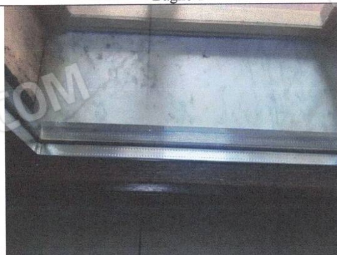
Particolare infisso esterno
