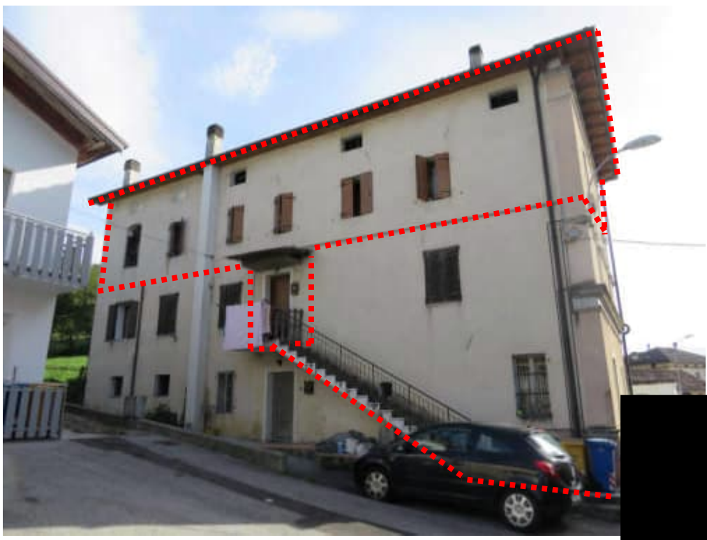
Individuazione dell'unità abitativa – prospetto sud/ovest
