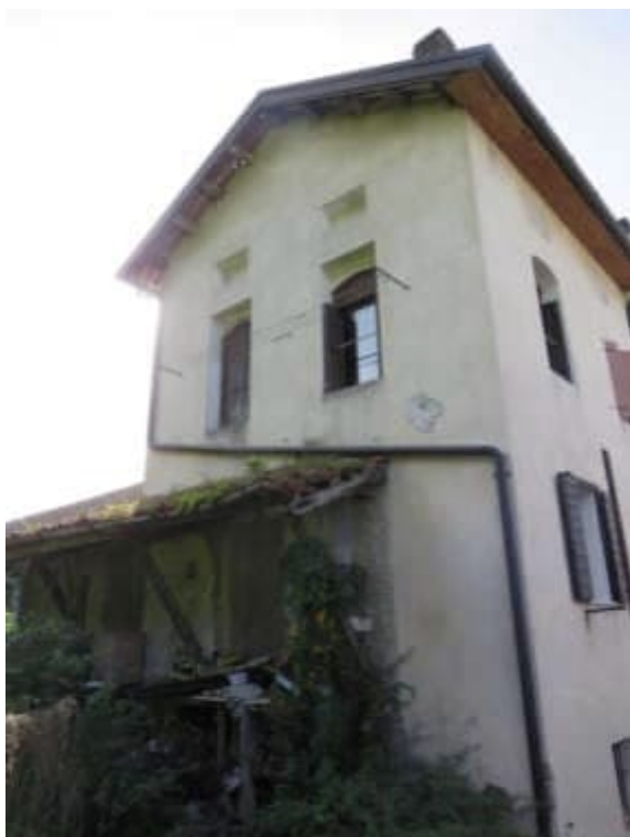
Scorcio vista prospetto nord/ovest
