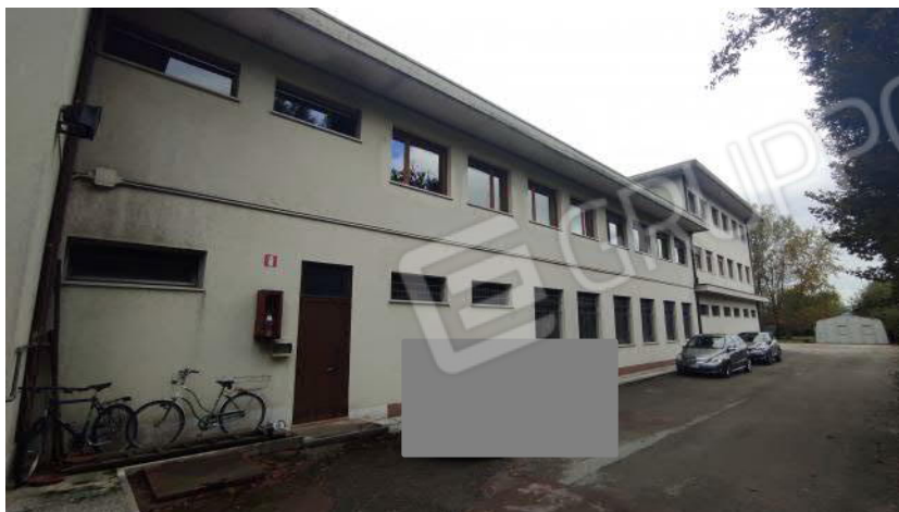
Vista a nord
