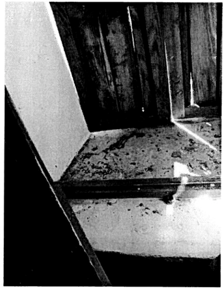
22 Particolare della finestra
