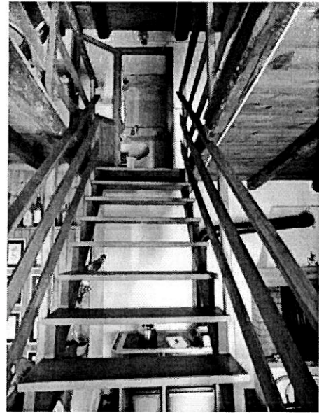
16 La scala d'accesso al 1° piano
