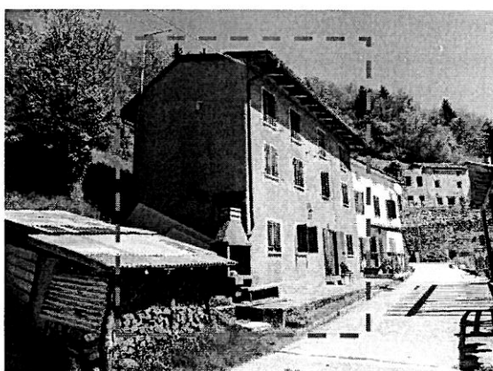
1 vista dalla strada, corte comune part. 111
