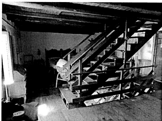
28 la scala di accesso al 2° piano
