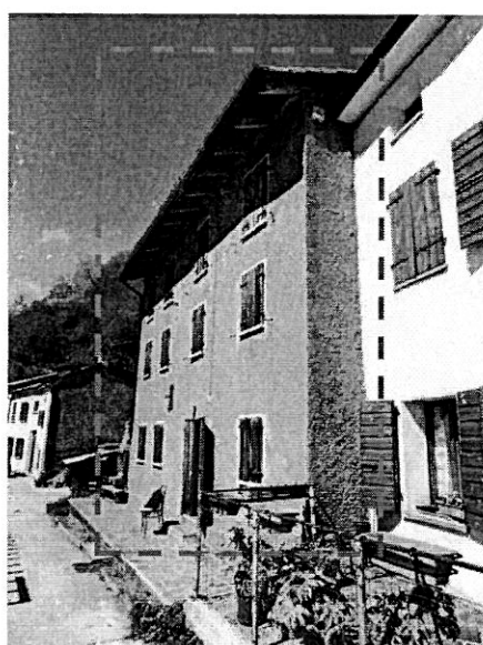
2 vista dalla strada, corte comune part. 111
