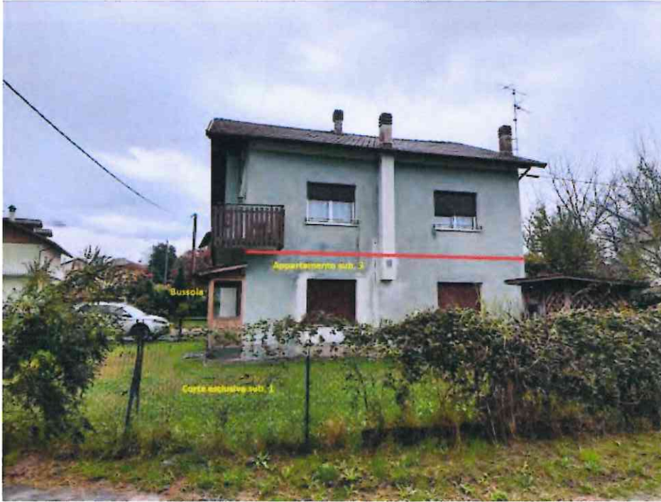
Foto lato ovest da via
