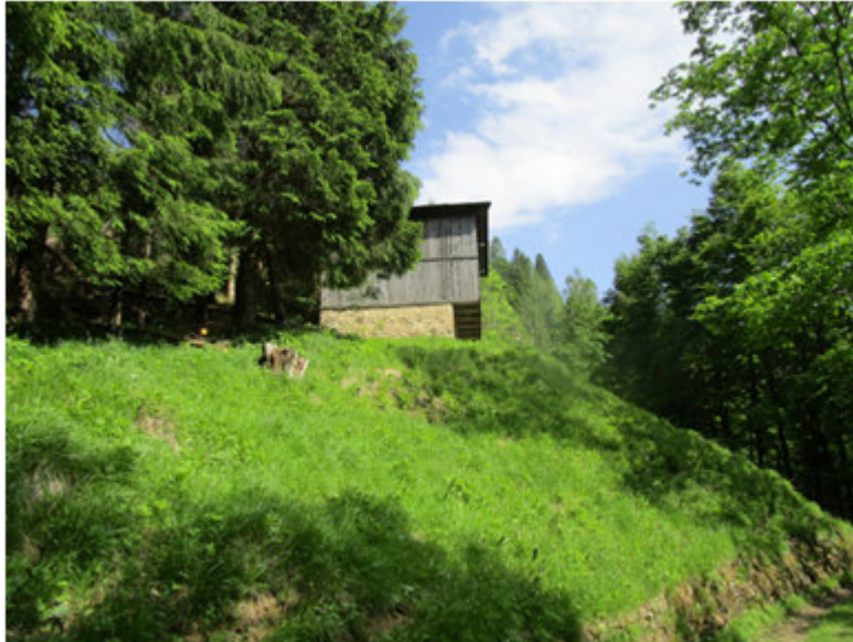
Vista fabbricato rurale
