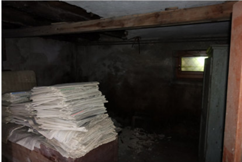
Vista vano PS2
