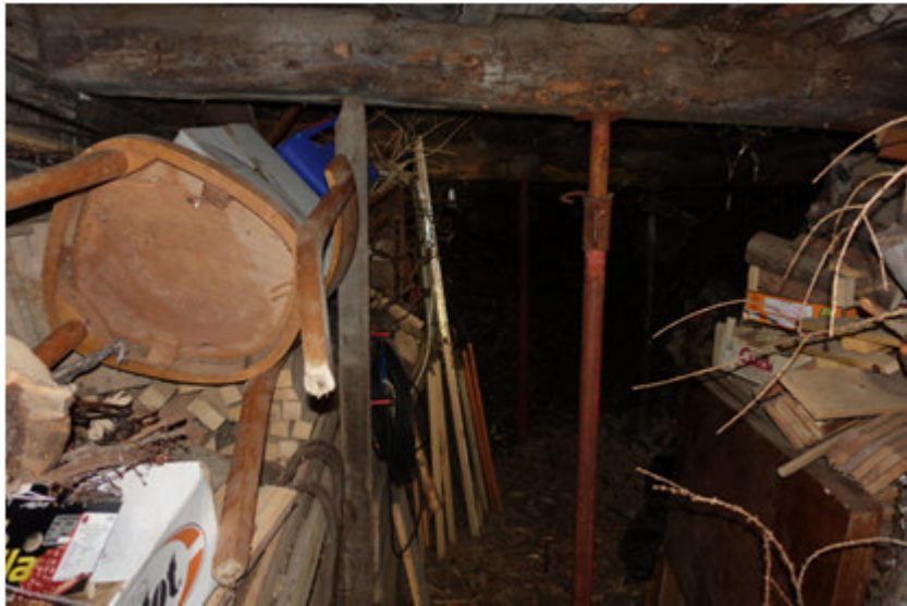
Vista interno immobile
