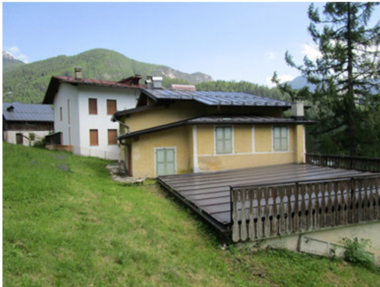
Vista terreni e copertura autorimesse
