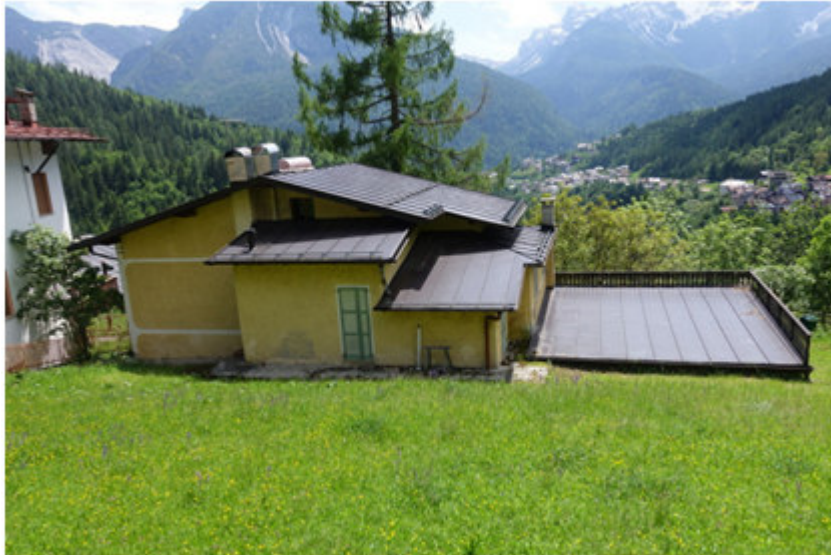
Vista fabbricato da nord
