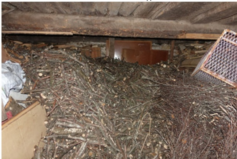
Vista interno immobile
