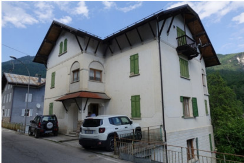
Vista fabbricato da strada comunale Via Vittorio Veneto
