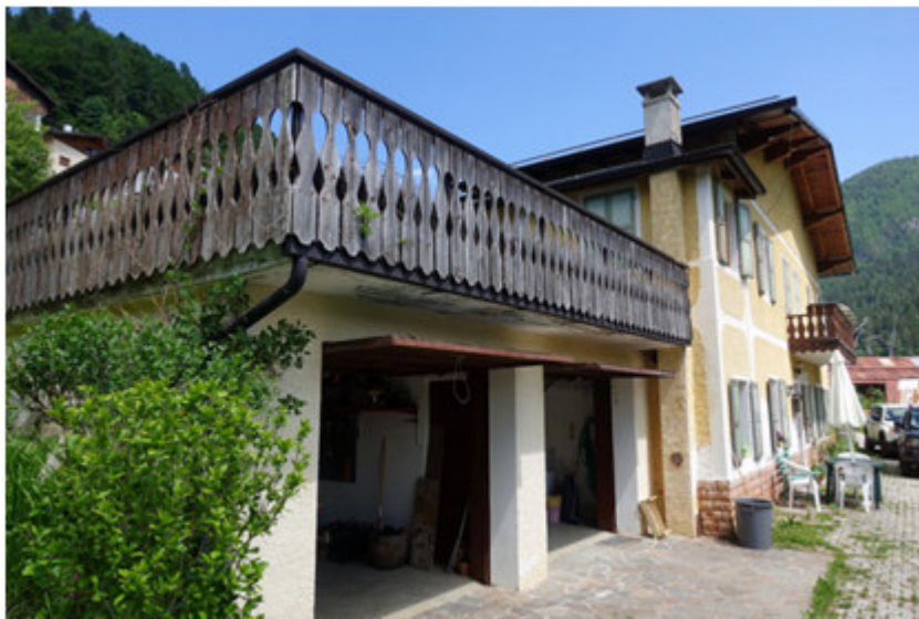
Vista fabbricato da ovest
