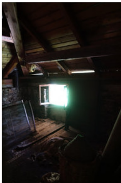
Vista vano al P2
