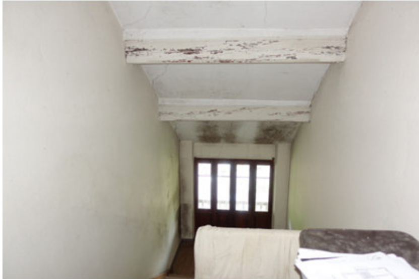
Vista vano scale P2
