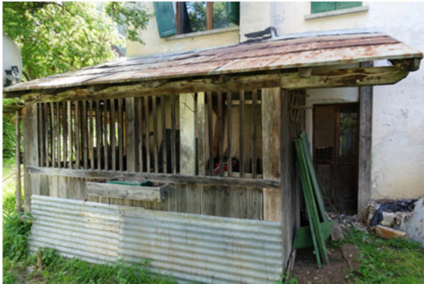
Vista deposito esterno a est
