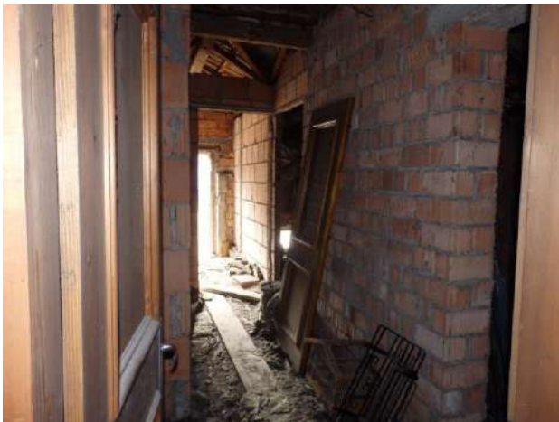
Piano terzo: soffitta
