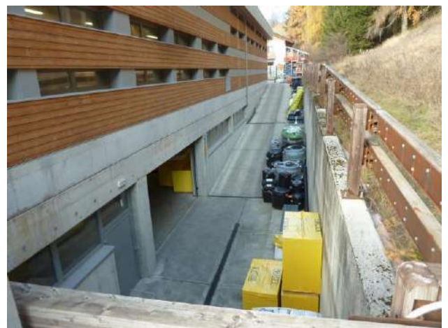
Rampa di accesso piano sottostrada
