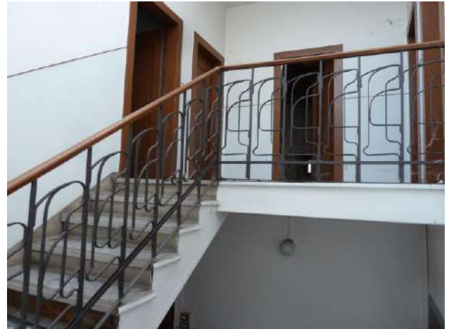
Vano scale - piano quarto
