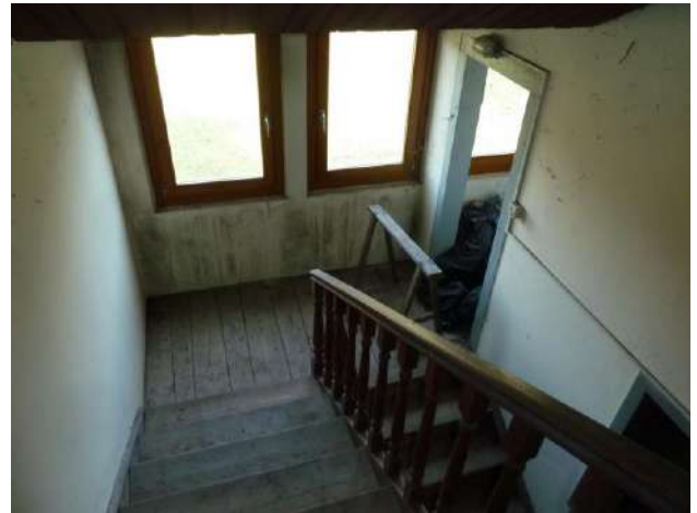
Piano terzo: vano scale
