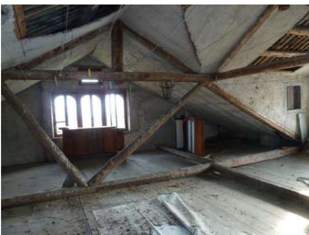
Piano terzo: soffitta
