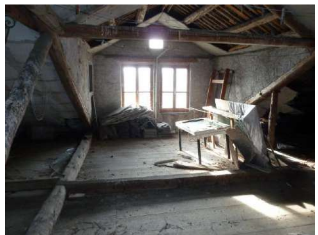
Piano terzo: soffitta
