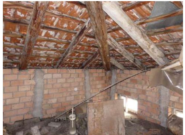
Piano terzo: soffitta
