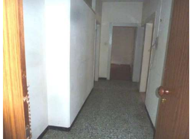
Corridoio piano terzo
