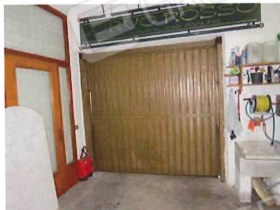
vista ingresso autorimessa sub.6
