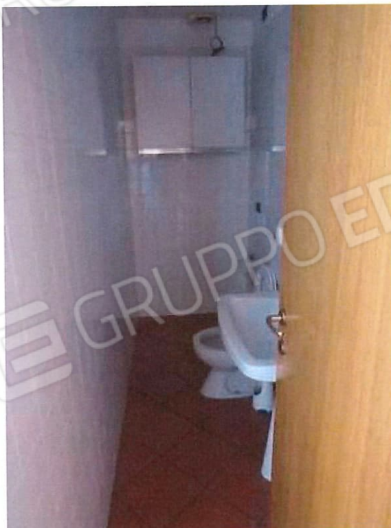
vista del servizio igienico a piano primo
