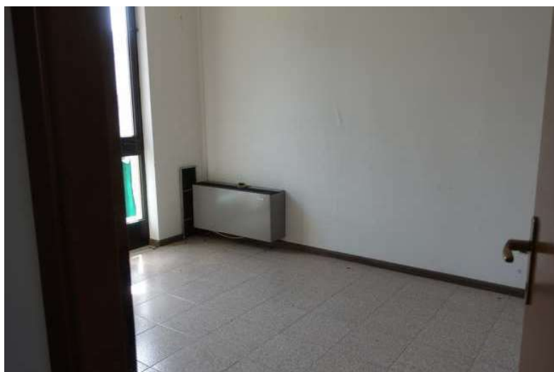
Vista vano interno
