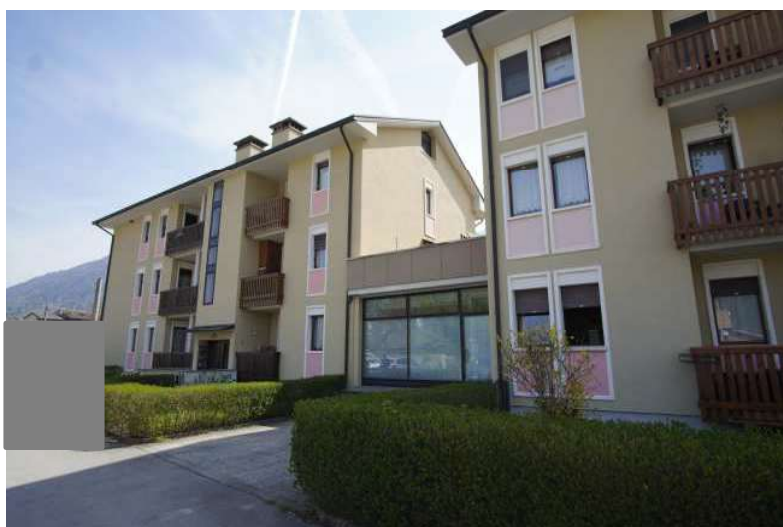
Vista fabbricato da nord
