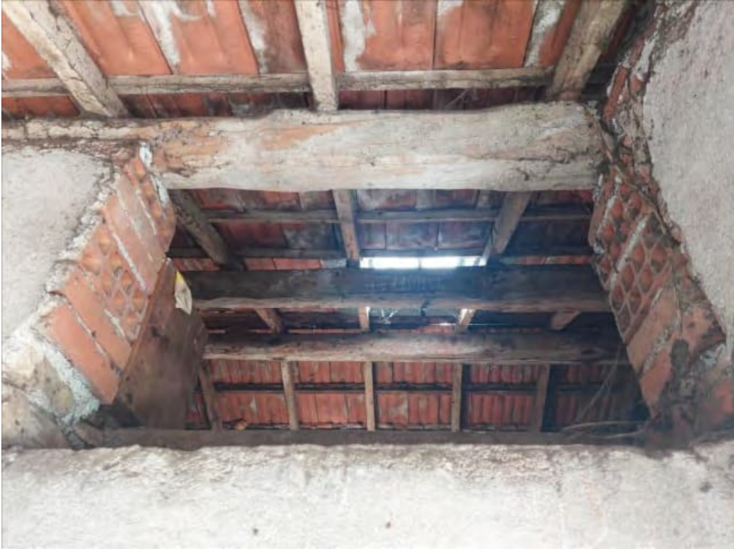
Sottotetto non abitabile
