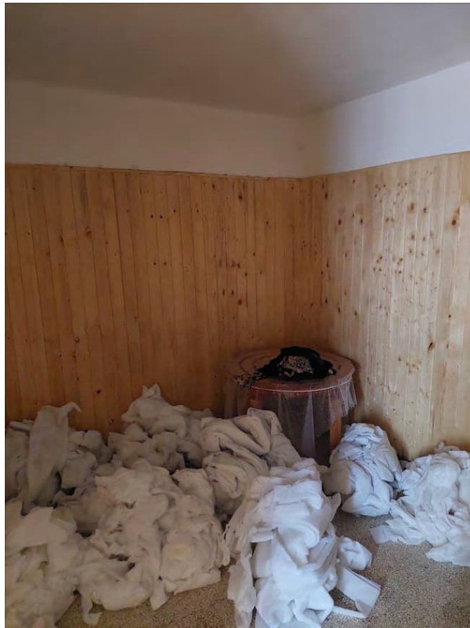
Vano PT lato est
