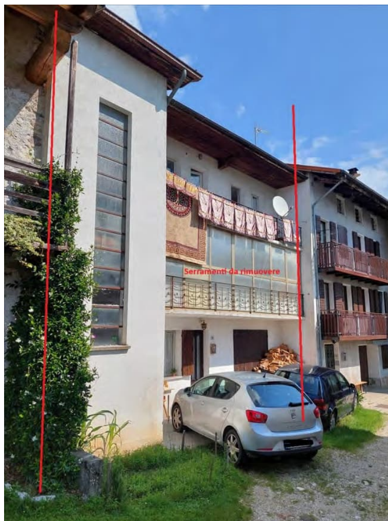
Lato sud con vetrata da rimuovere
