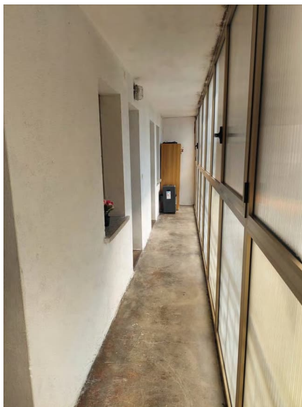
Terrazzo P1 con vetrata da rimuovere
