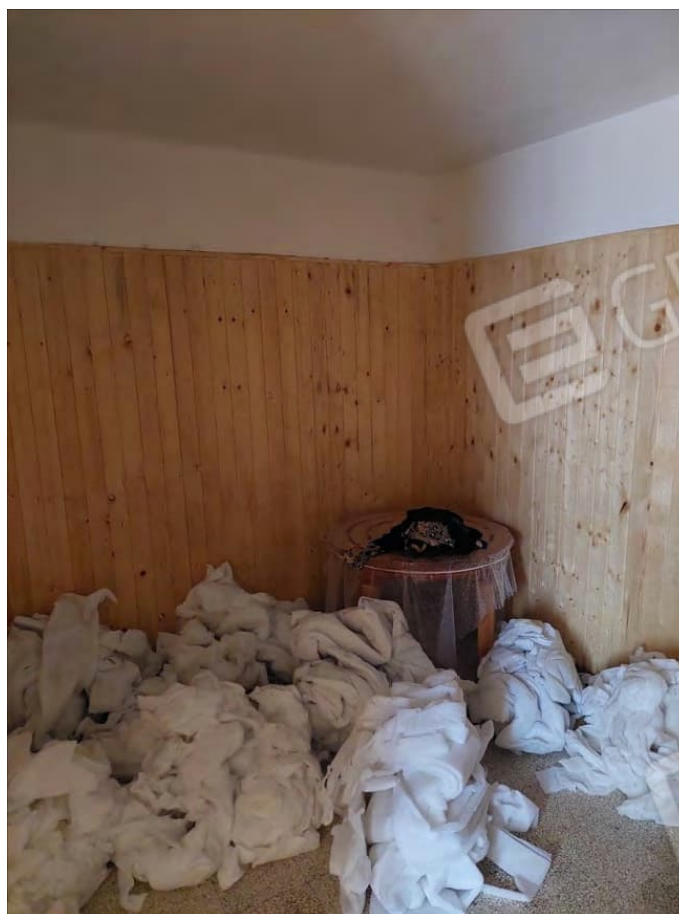
Vano PT lato est
