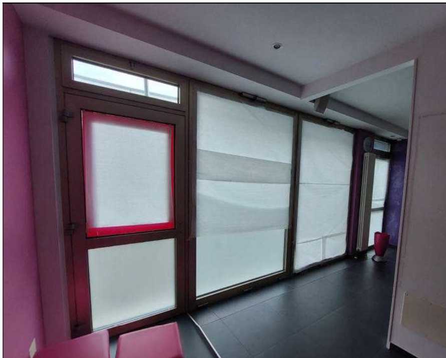
Figura 8: ingresso principale al centro estetico in alluminio anodizzato
