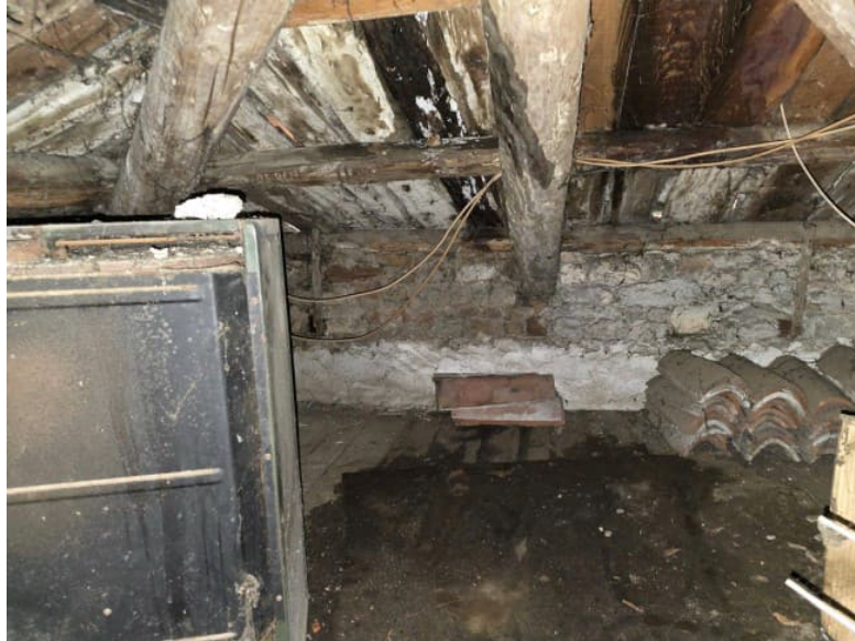
Piano secondo, soffitta comune
