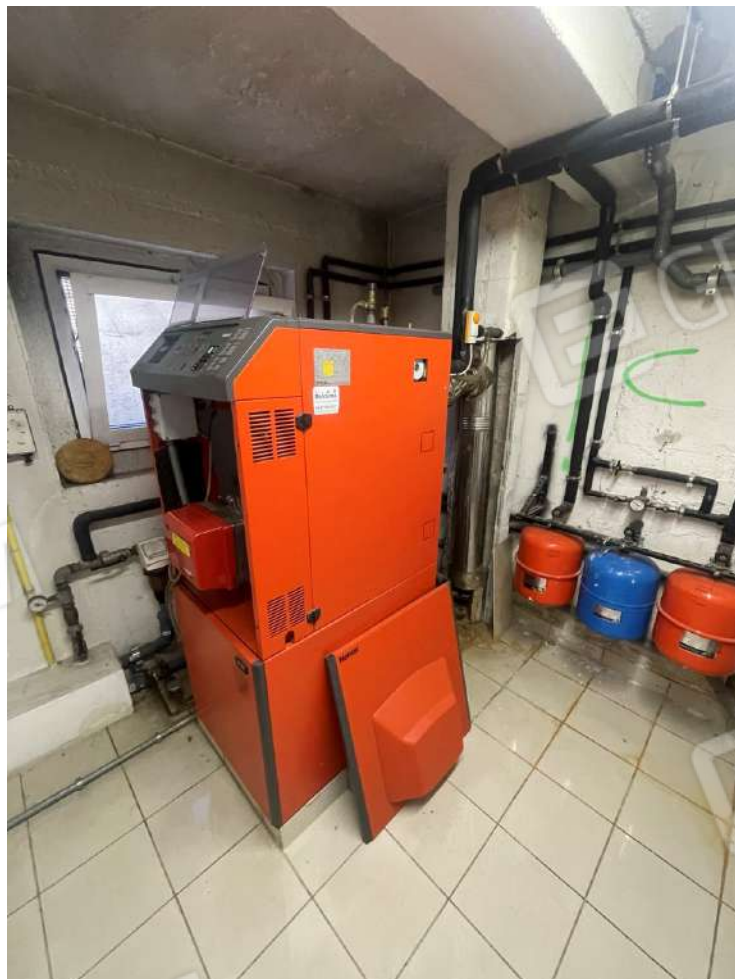
Foto 22 – Caldaia alimentata a gasolio (PS1)
