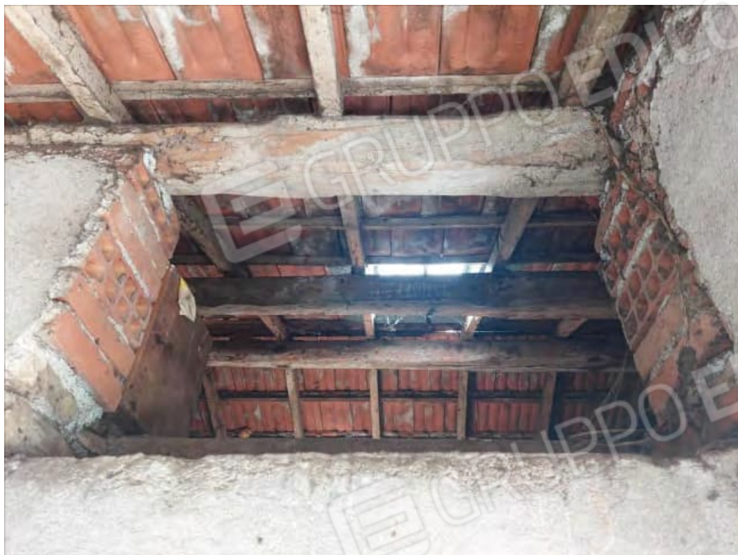
Sottotetto non abitabile
