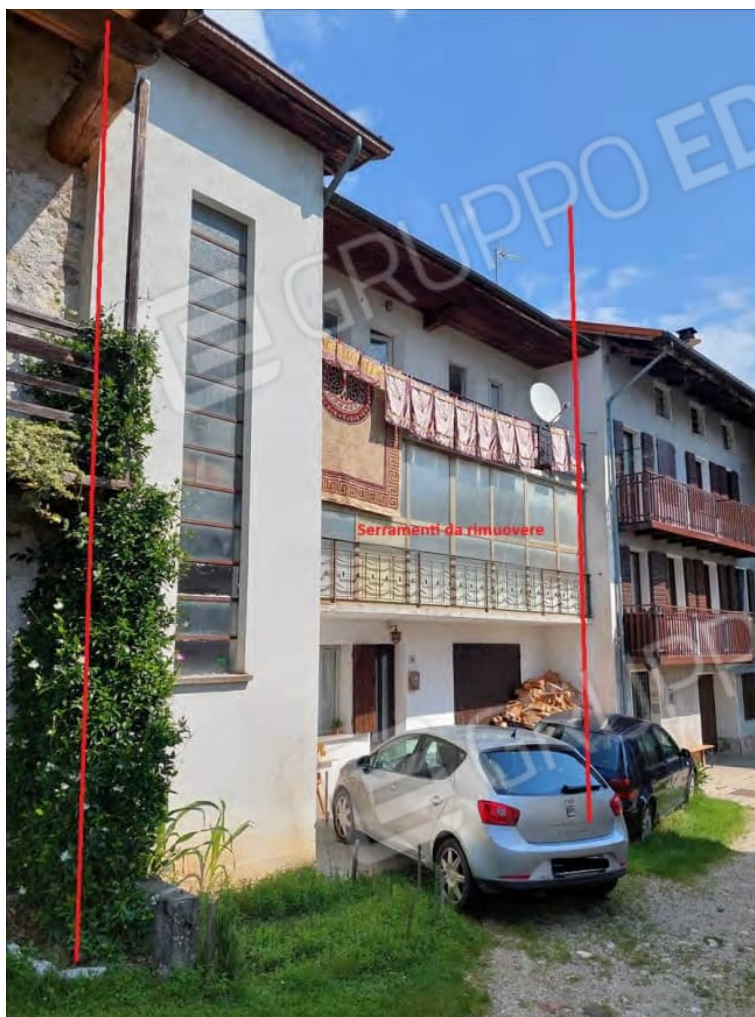
Lato sud con vetrata da rimuovere
