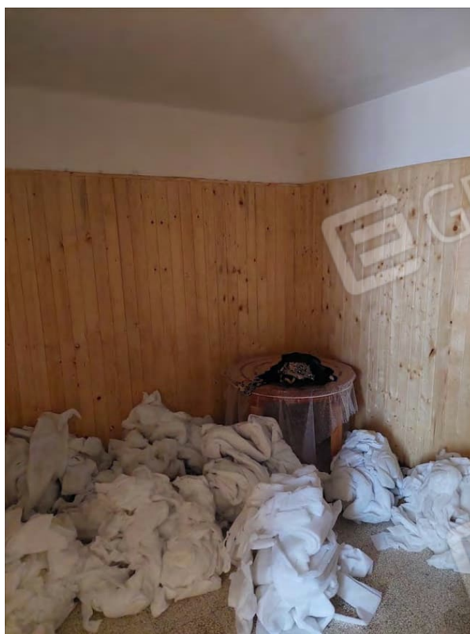
Vano PT lato est
