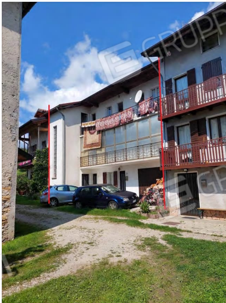
Lato sud dalla corte interna
