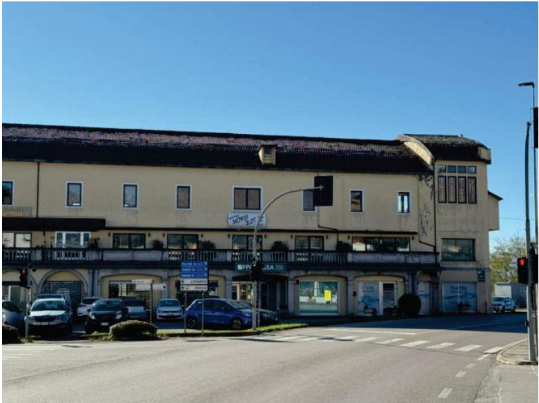
Foto panoramica esterna (nord)
