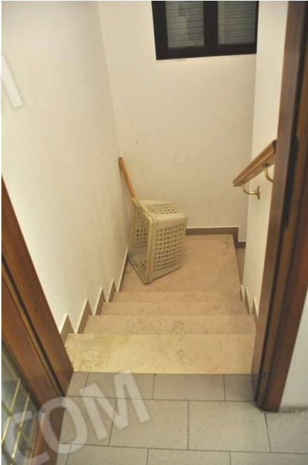
54 – Scala di accesso all'interrato
