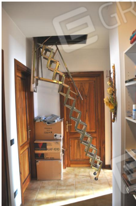
27 – L'accesso al sottotetto dal corridoio zona notte
