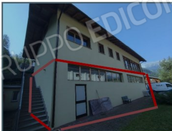
fronte nord-est piano terra
