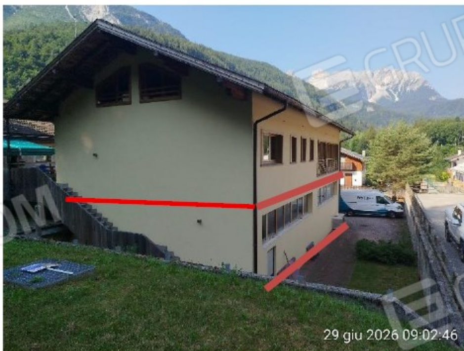
Fronte nord-ovest piano terra
