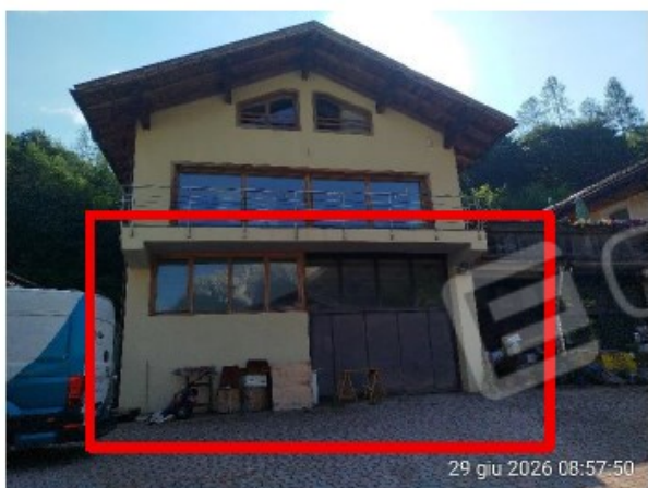
Fronte nord-ovest, piano terra
