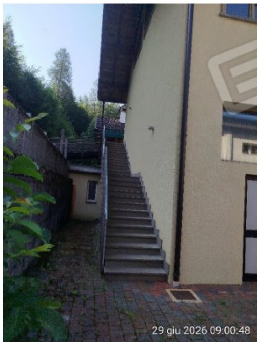
Scala che conduce al primo piano
