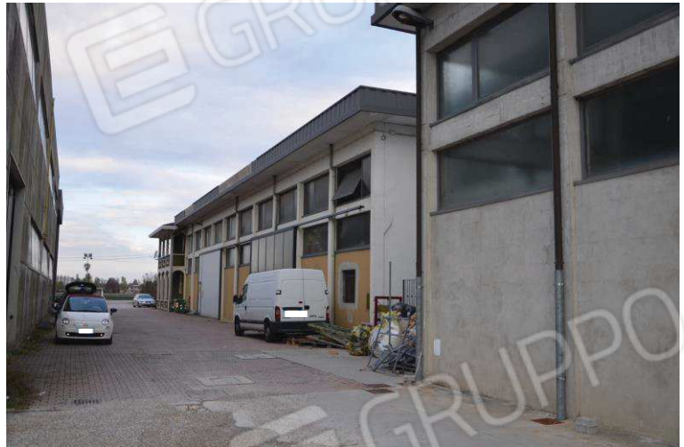
FOTO 2 | Prospetto laterale (sud)
