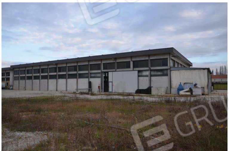
FOTO 18 | Prospetto laterale (sud)
