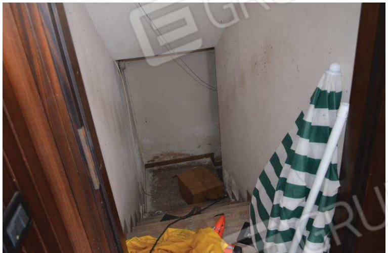
FOTO 33 | Scala di accesso alla cantina
