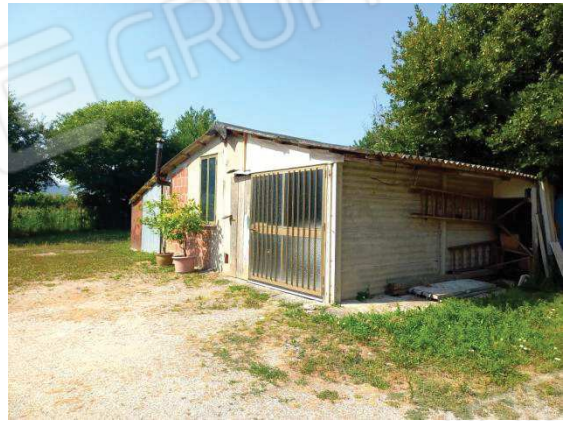
FOTO 9 / ANNESSO A SUDOVEST
