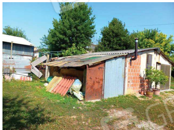
FOTO 9 / ANNESSO A SUDOVEST
