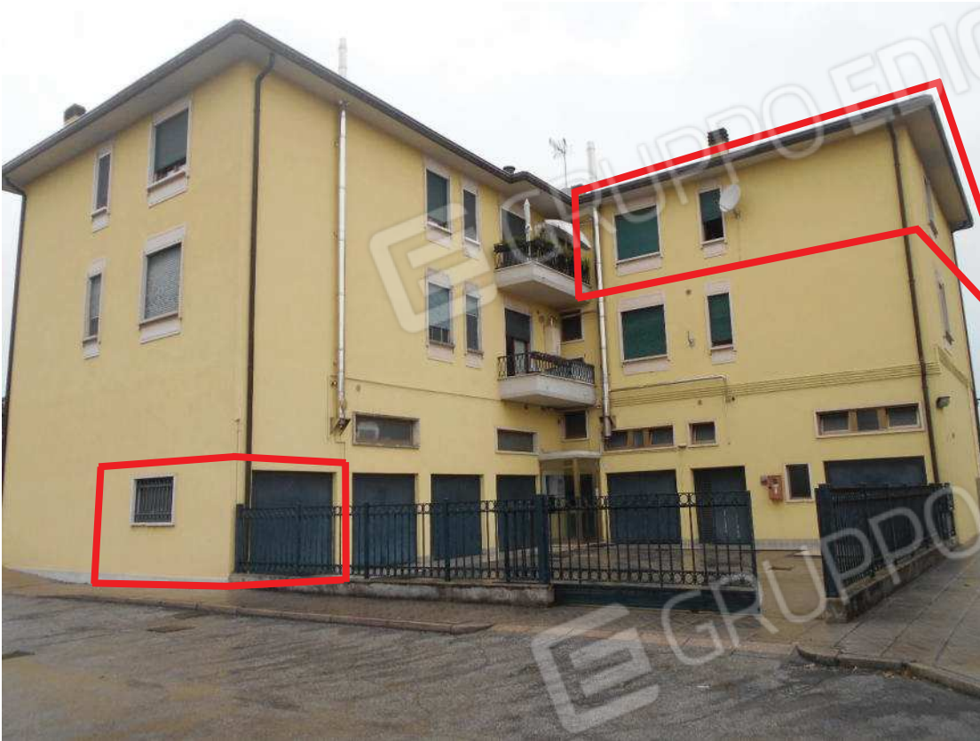
Foto 4: fabbricato condominiale, vista da sud-est. Riquadrato in rosso appartamento e garage pignorati
