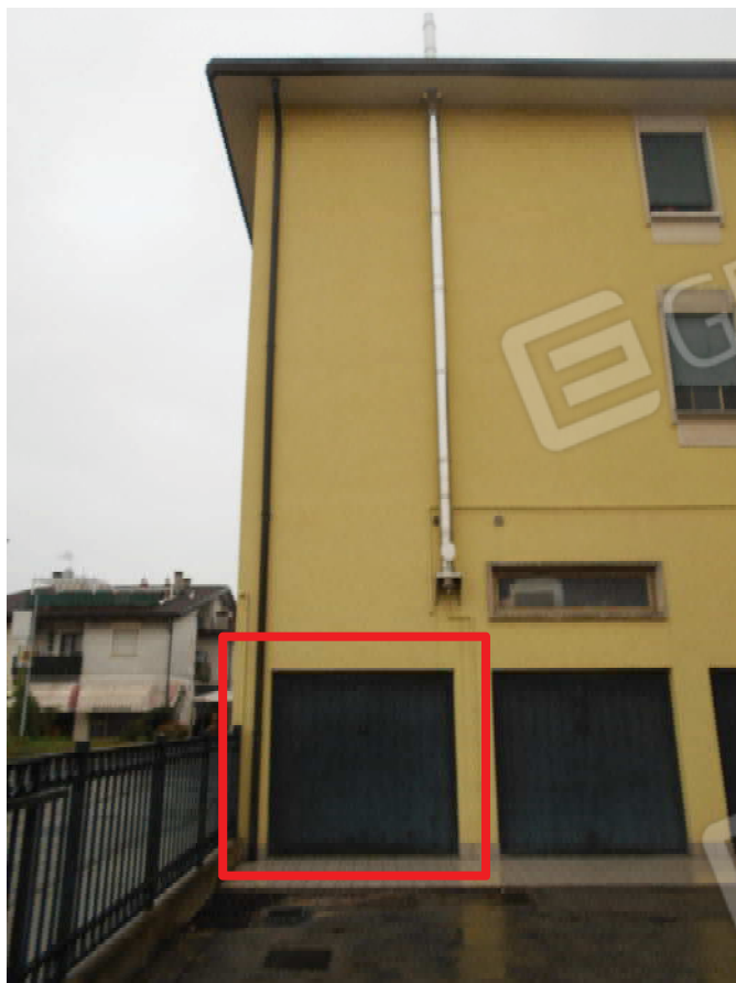
Foto 6: particolare facciata est, garage (sub. 31)
