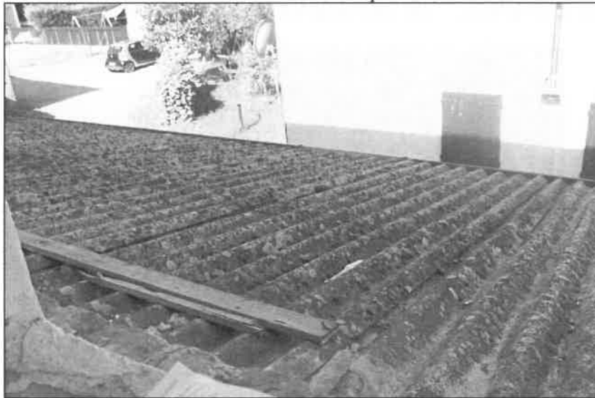
Copertura in Eternit
