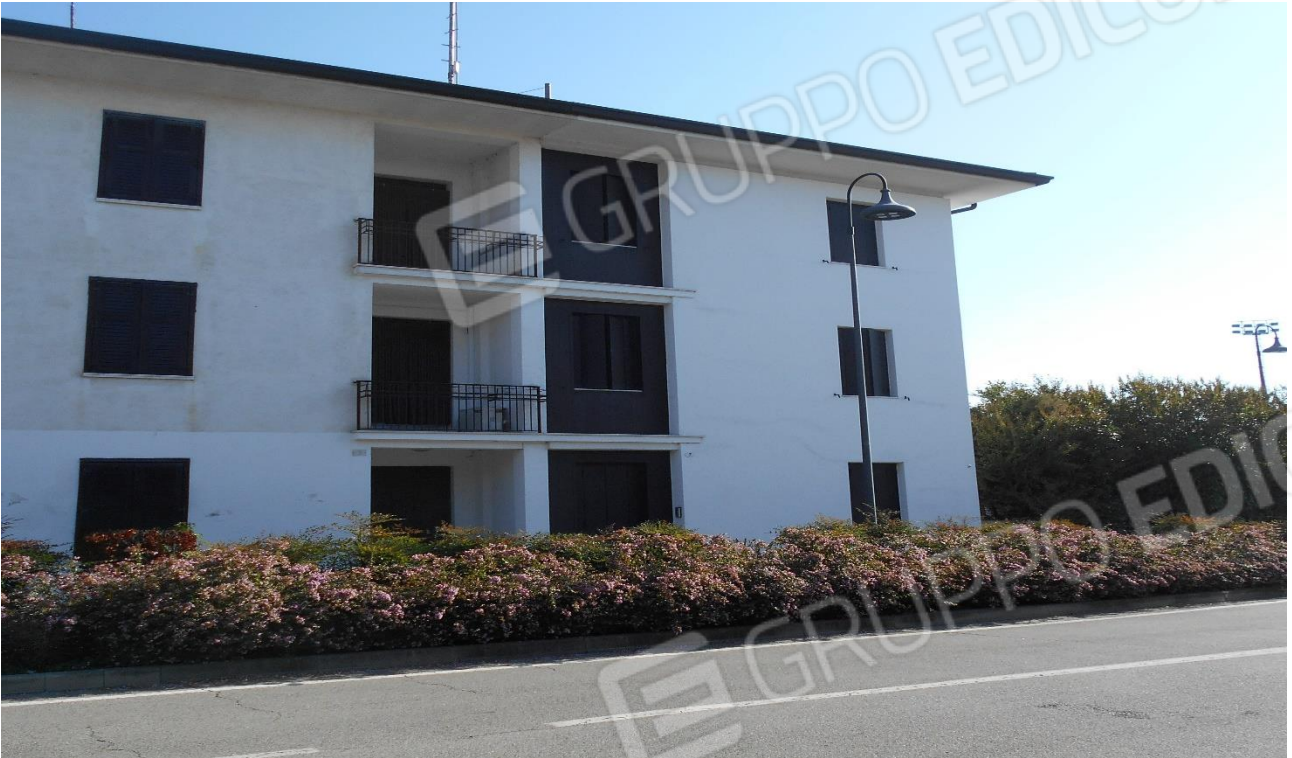
Foto n° 1 – Fabbricato prospetto est – Viale Venezia n.7
