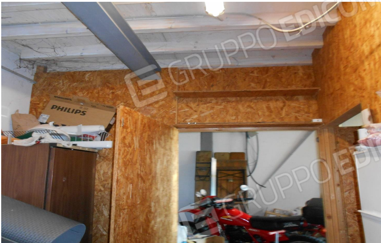
Foto n° 4 – Ripostiglio e garage piano terra
