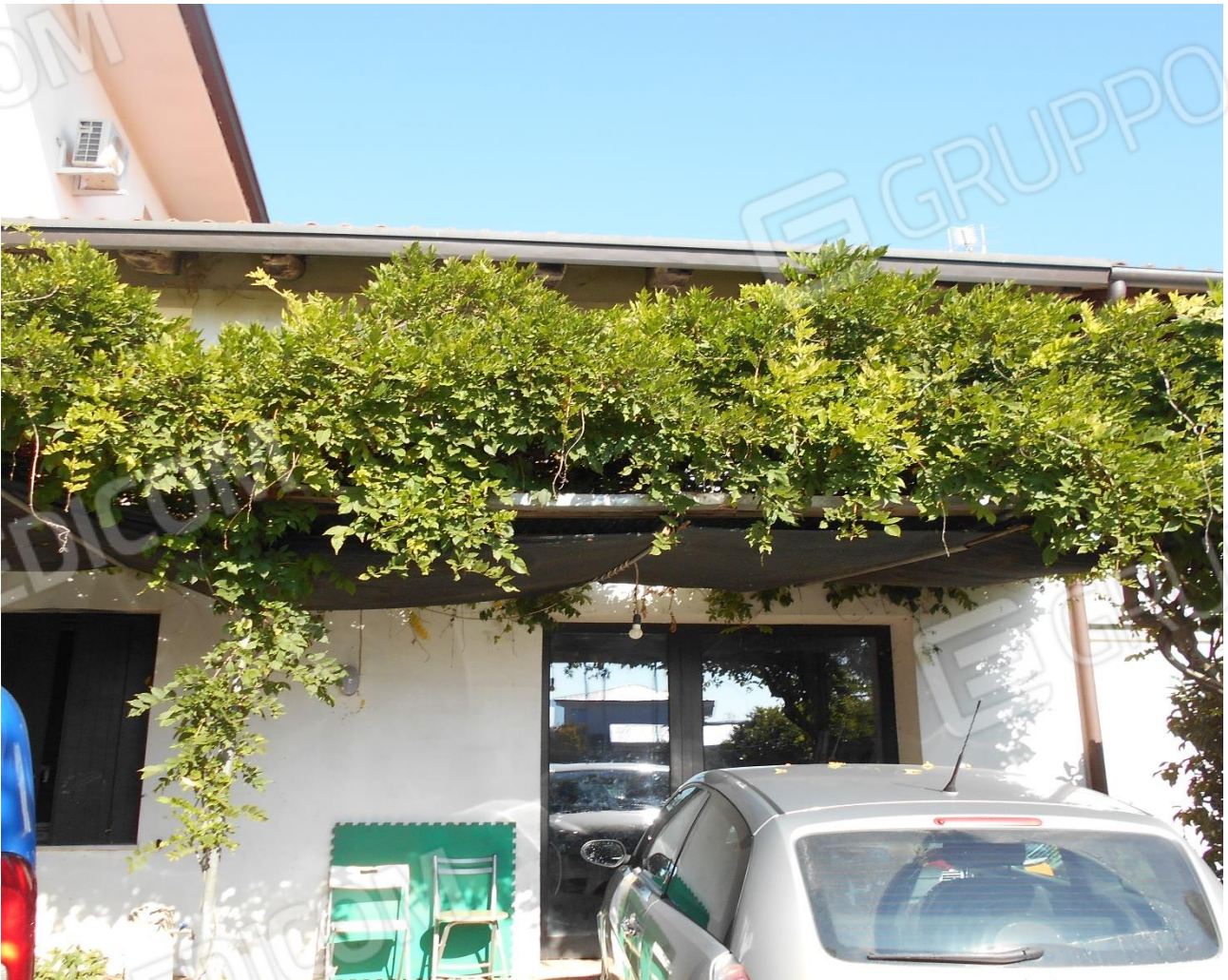
Foto n° 2 – Fabbricato prospetto sud – ingresso garage
