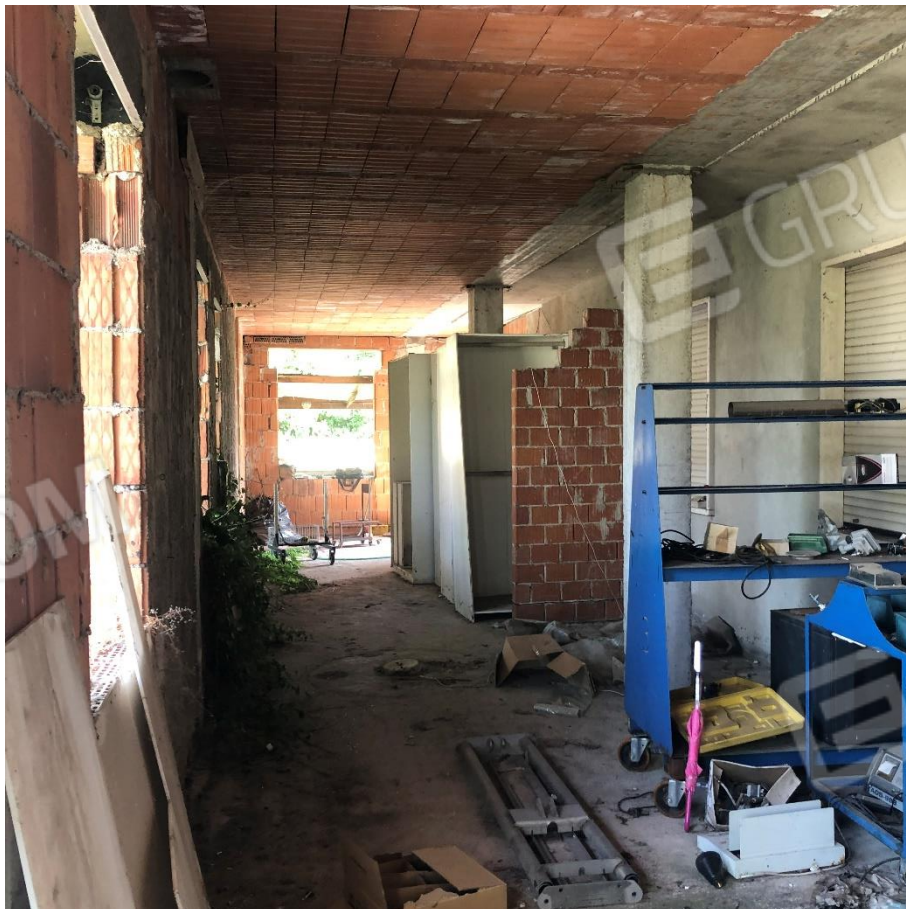
foto n. 20 – porzione di laboratorio allo stato grezzo
