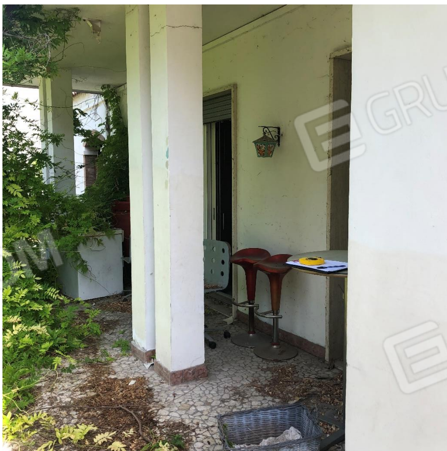
foto n. 24 – portico (lato sud)
