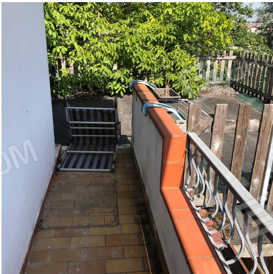
foto n. 16 – poggiolo e copertura laboratorio
