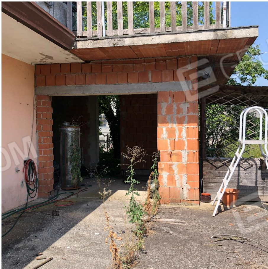
foto n. 22 – ingresso laboratorio allo stato grezzo
