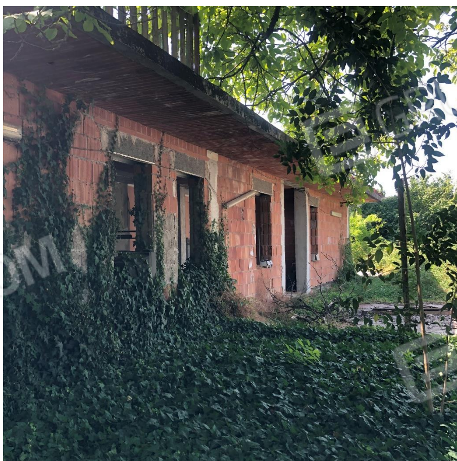
foto n. 4 – facciata ovest fabbricato
