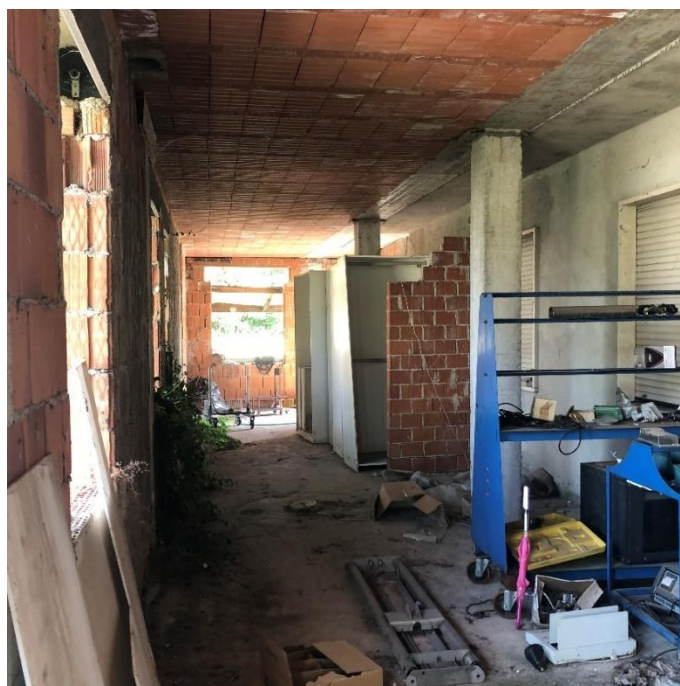
Figura 7 – Interno della porzione di laboratorio ancora al grezzo
