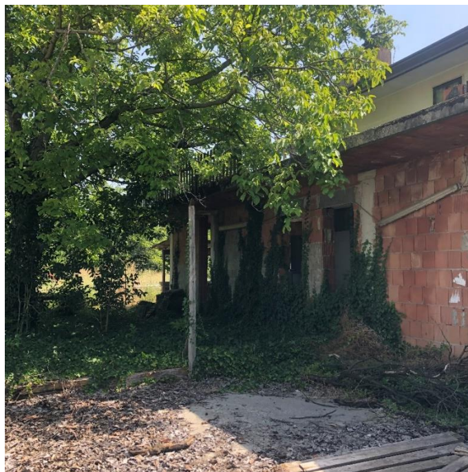
Figura 6 – Facciata ovest del fabbricato
