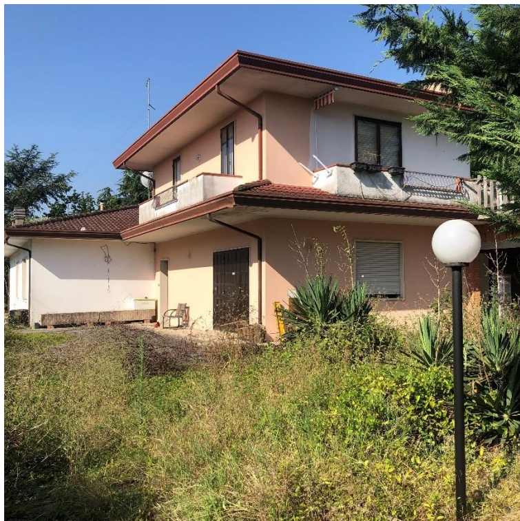
Figura 5 – Angolo nord-est del fabbricato
