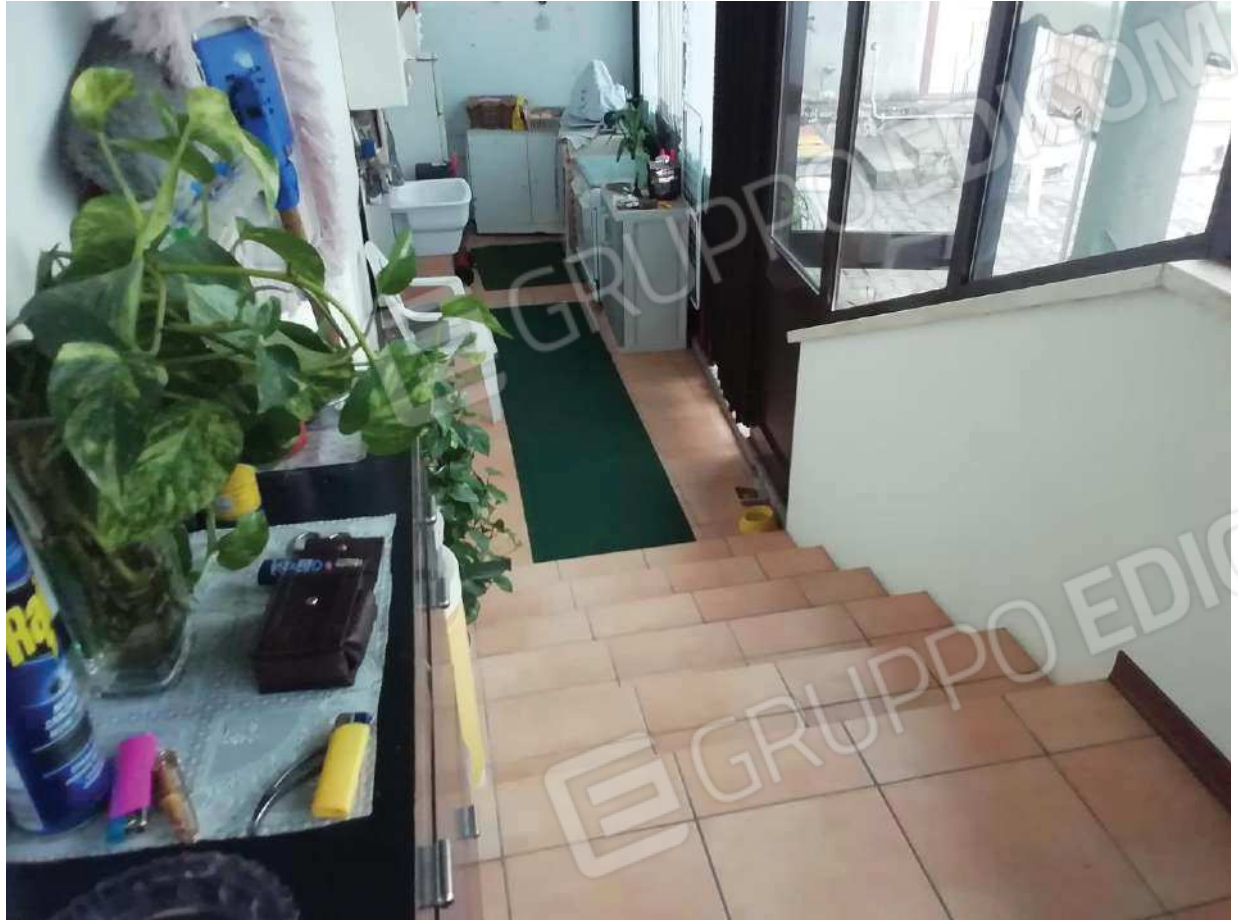
Foto n.10B – veranda abusiva
