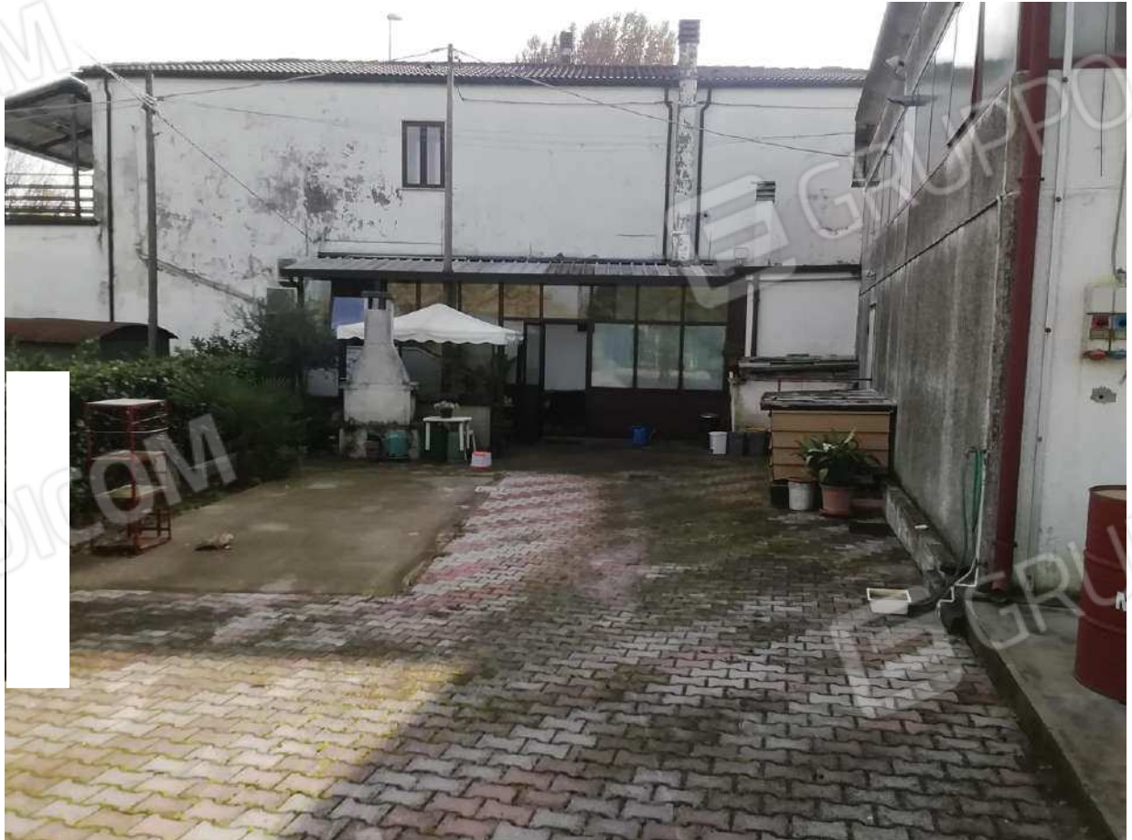
Foto n. 11B – area scoperta di terzi
