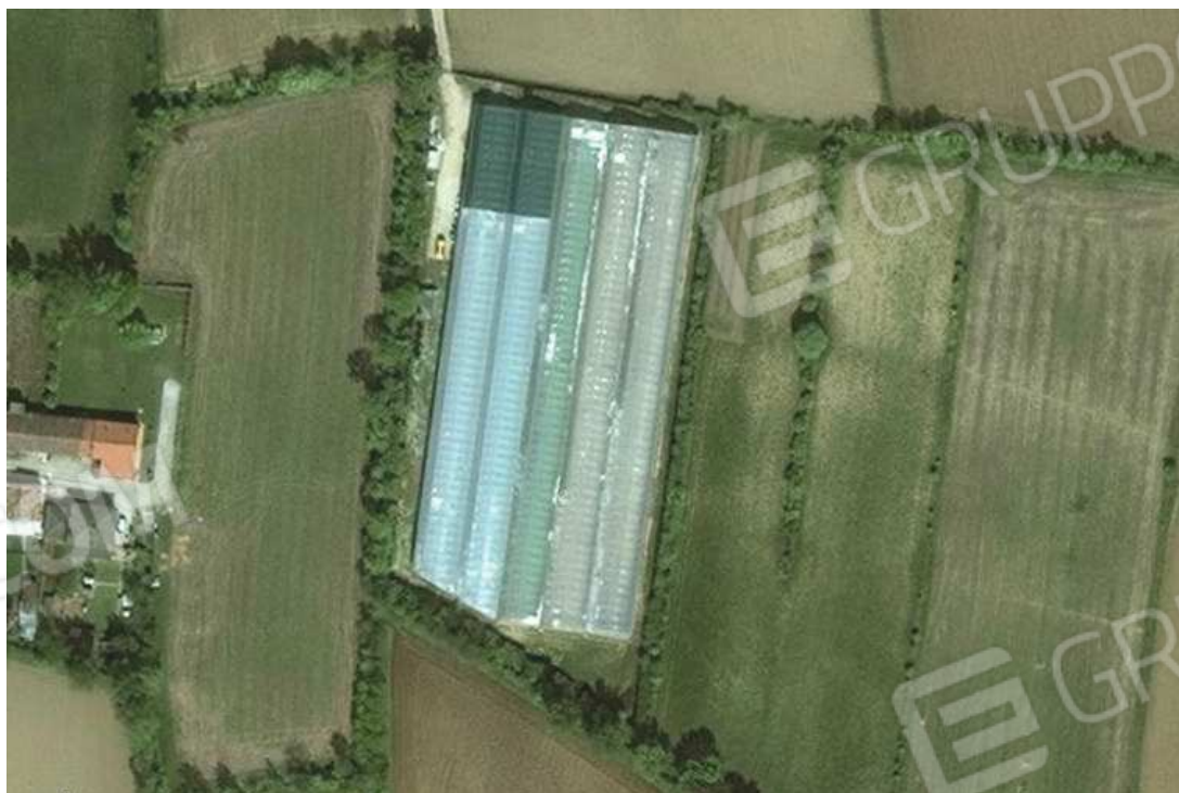
17. Vista sul complesso serricolo della particella 185.
