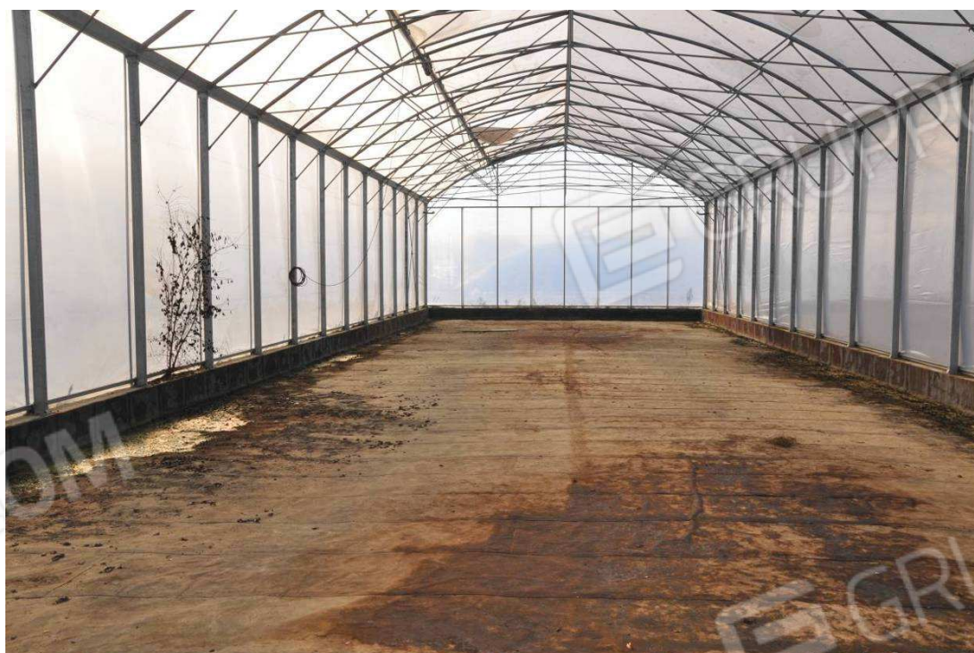
39. Particolare dell'interno dell'edificio F
