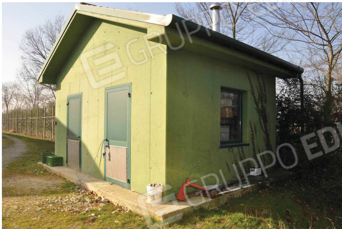
36. Vista da nord dell'edificio E
