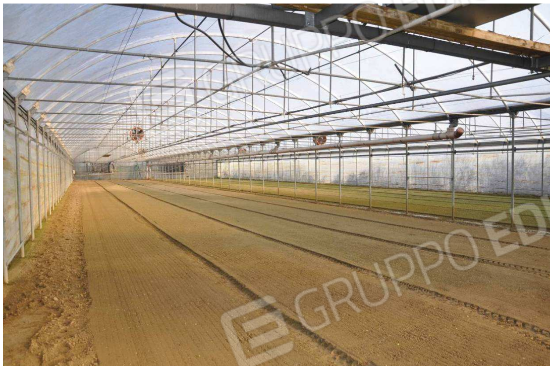
38. Particolare verso nord dell'interno dell'edificio B
