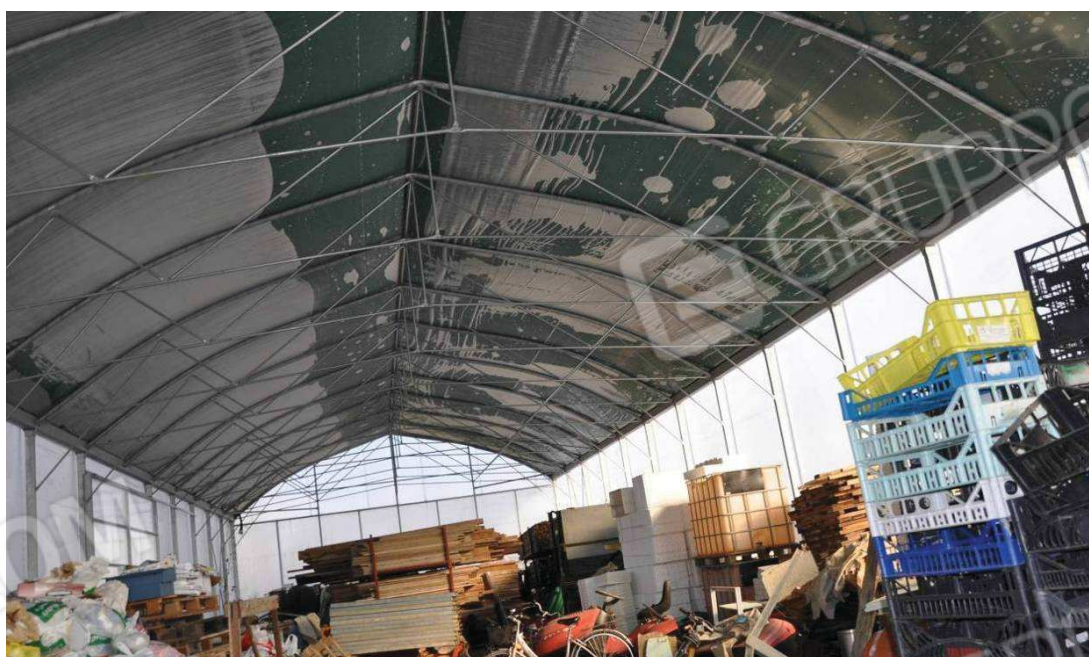
35. Particolare dell'interno dell'edificio C.
