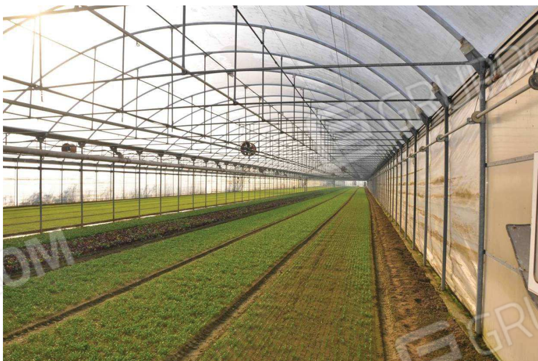
37. Particolare verso sud dell'interno dell'edificio B
