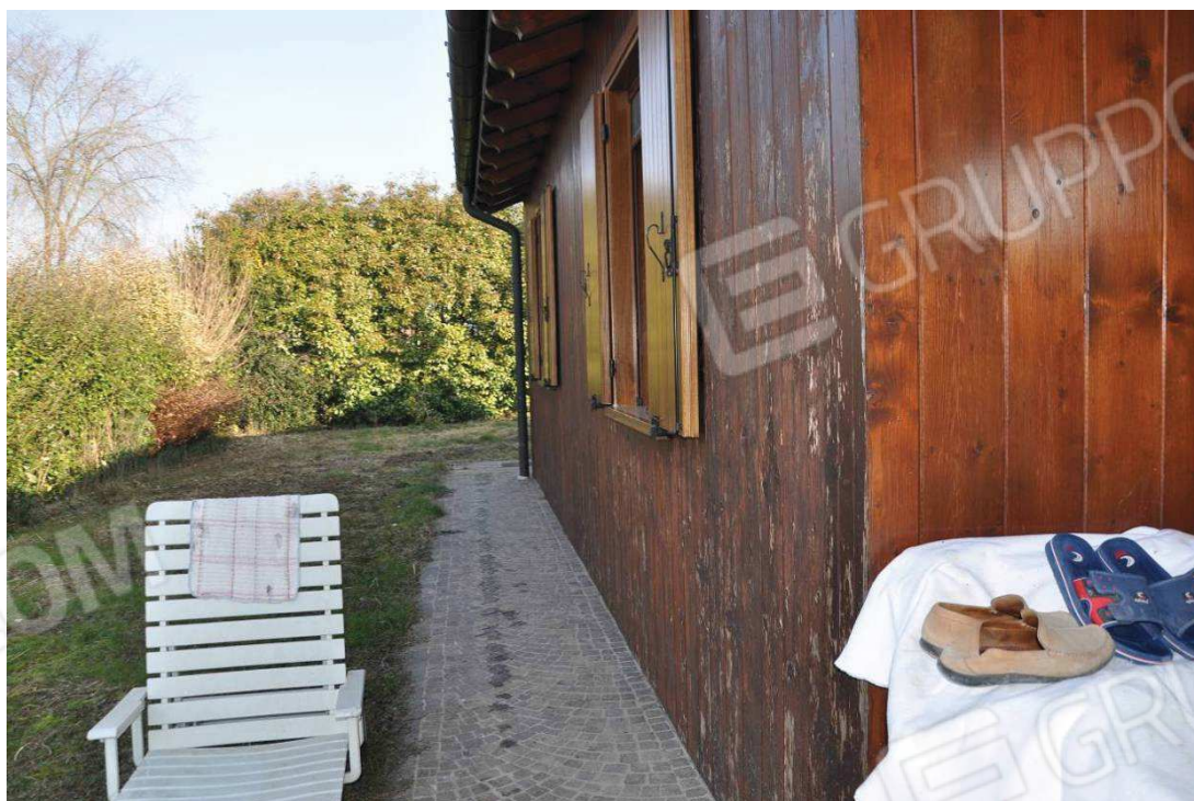
31. Vista lato ovest edificio A
