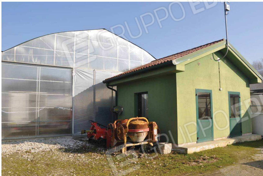
34. Vista da sud dell'edificio C sulla sinistra, e dell'edificio D sulla destra.
