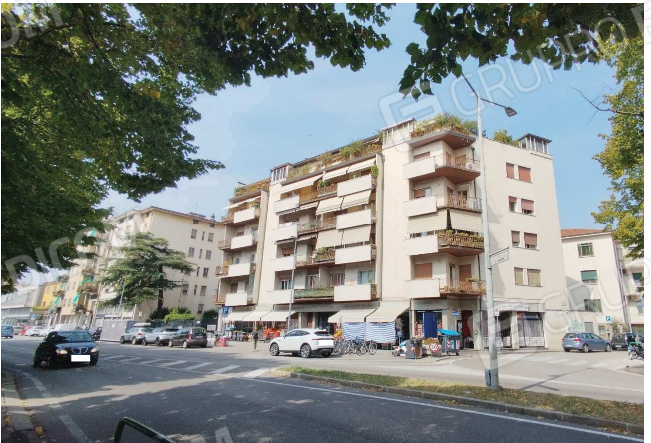
Veduta esterna del condominio
