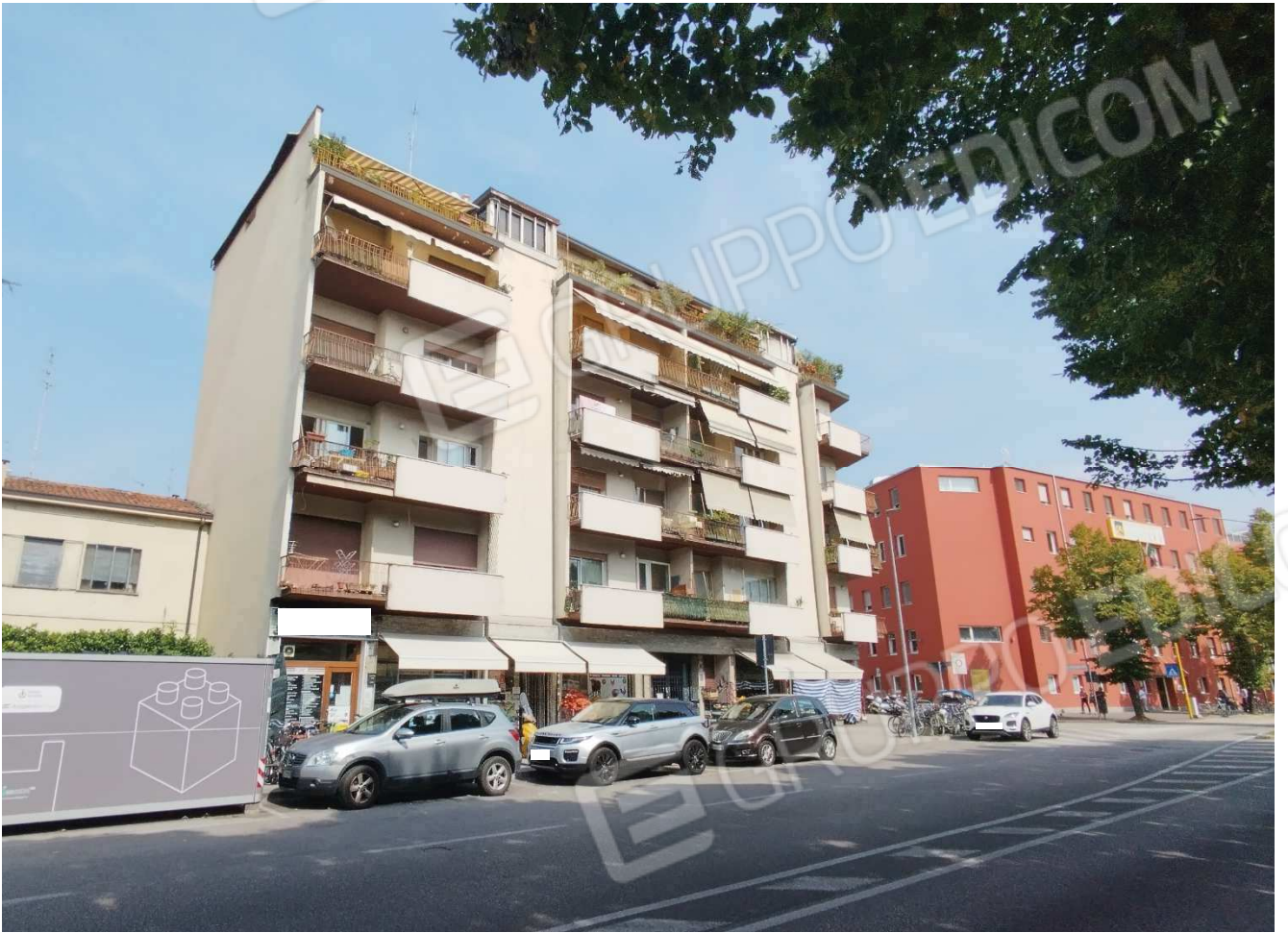
Veduta esterna del condominio
