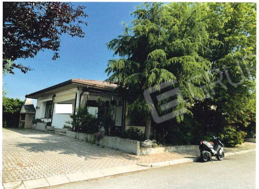
Fabbricato oggetto di E.I. Vista Sud-ovest
