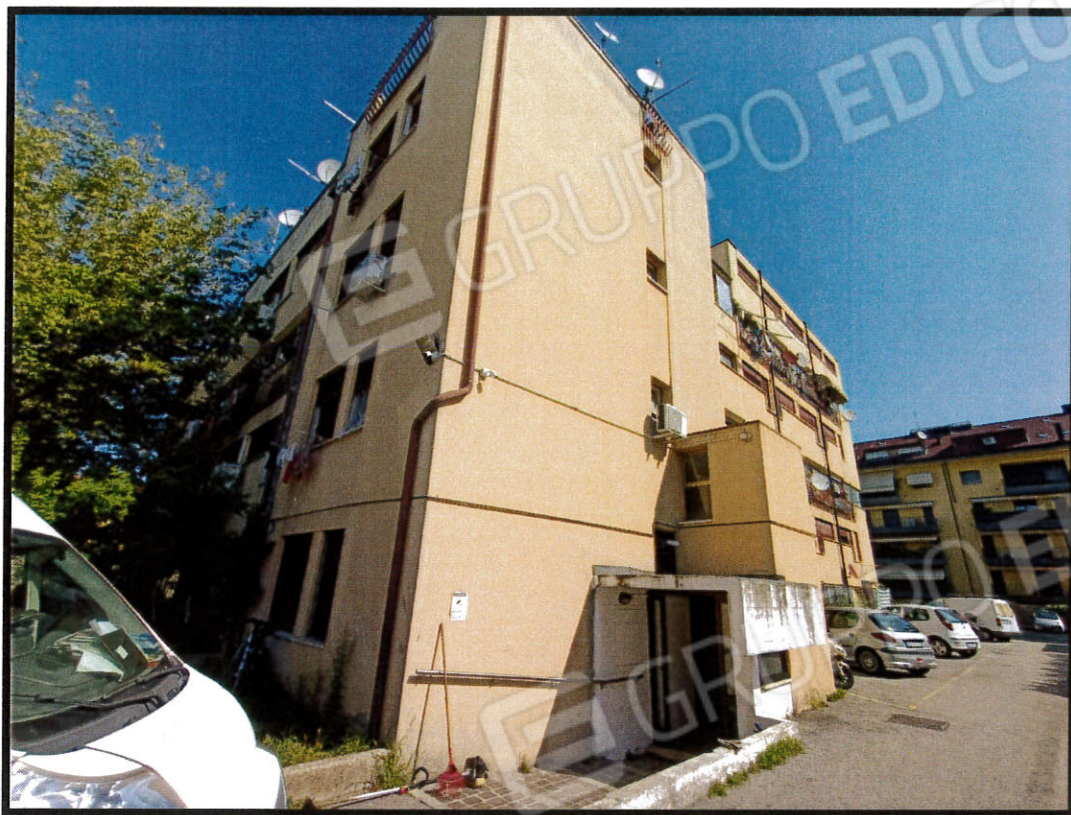
Foto n. 1: Vista ingresso condominiale, prospetto Sud.
