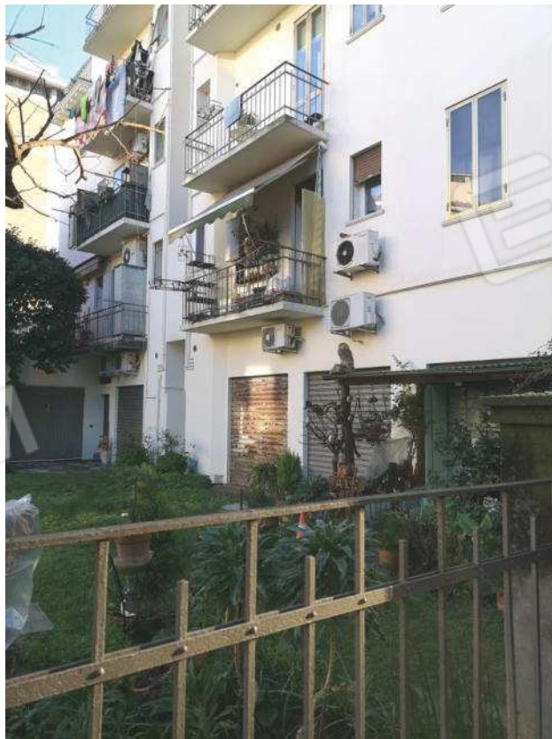
Vista Nord – accesso garage
