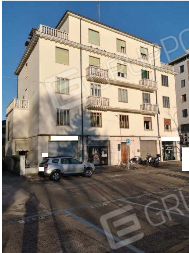
Vista Sud – vicolo Aspetti
